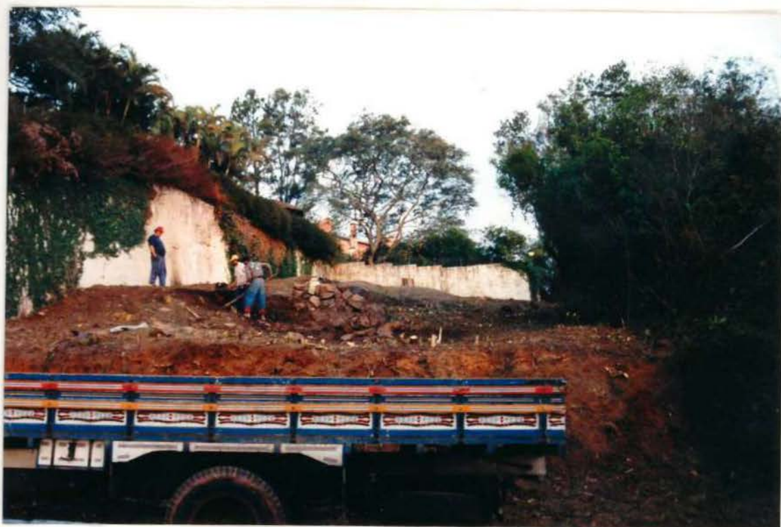
Fig. 16. Flagrante do corte total de mata em um terreno nas proximidades do Parque.
