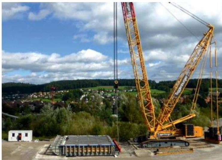
Figura 31: Vista geral do ensaio em escala real de campo realizado em Winterthur Geobruigg (2012)
