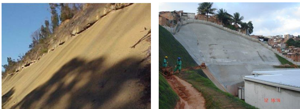
Figura 12: Exemplos de aplicação de concreto projetado. (a) talude rodoviário RTA (2005) (b) talude urbano ( solotrat.com.br acessado em 08/06/2014)
