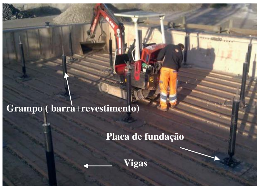
Figura 32: Vista interna da estrutura de madeira, Geobrugg (2012)
