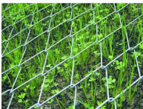
Figura 18: Tela metálica associada a sistema de controle de erosão com vegetação densa. Fonte: Yoko (2006).
