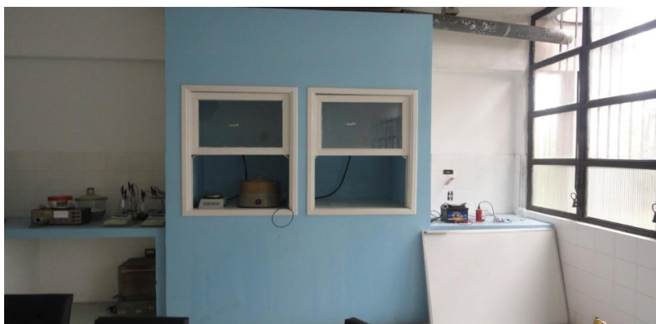
Figura 4: Laboratório 2, área das capelas que não contam com exaustão.
