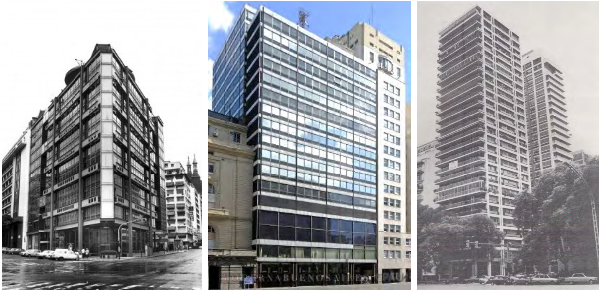
Fig. 43: Edifício Somisa, Mario Roberto Alvarez, 1971-1978.
