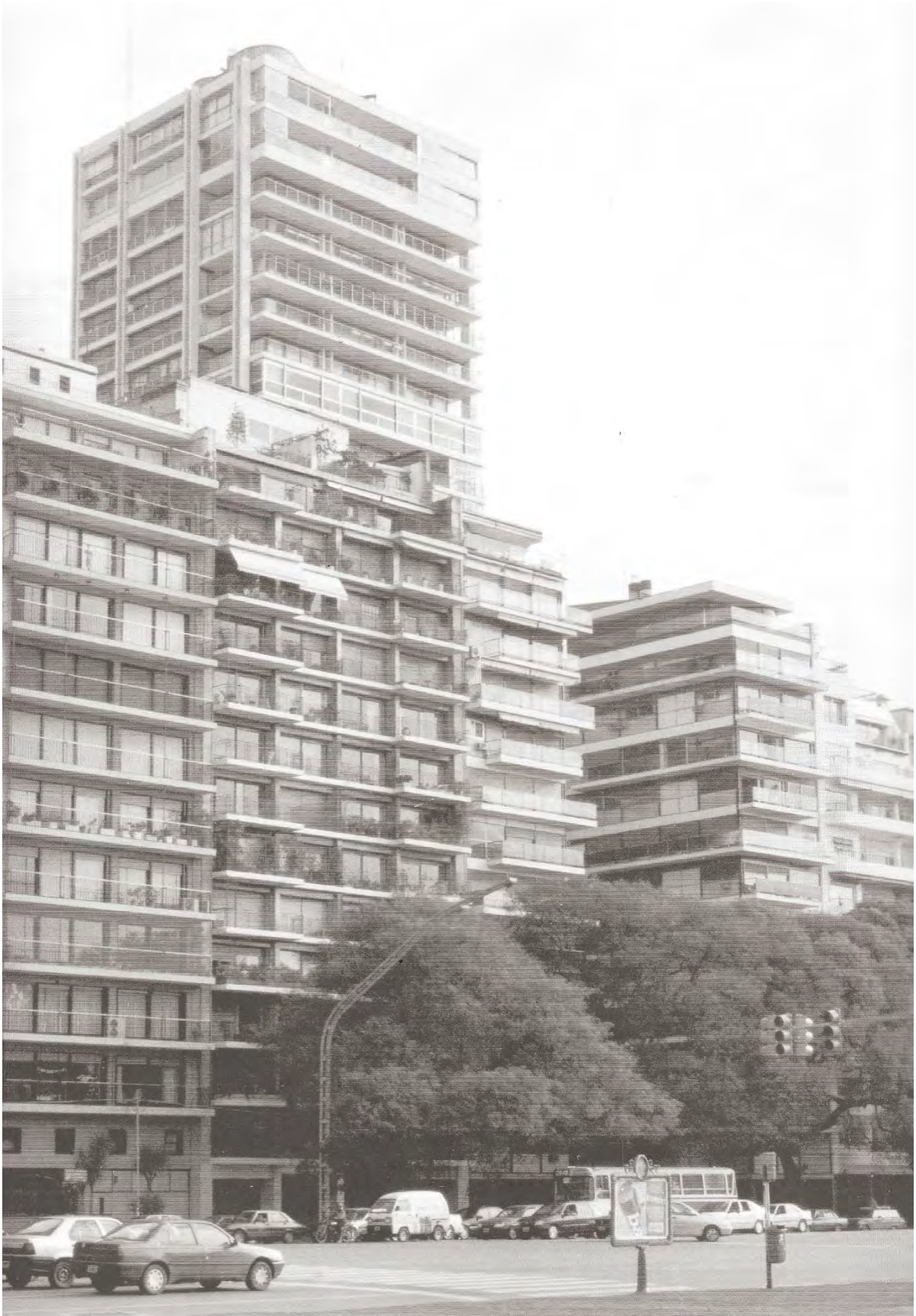
Fig. 167: Vista desde a Av. del Libertador mostrando a obra inserida no contexto urbano. Edifício Panedille, 1964-1969.
