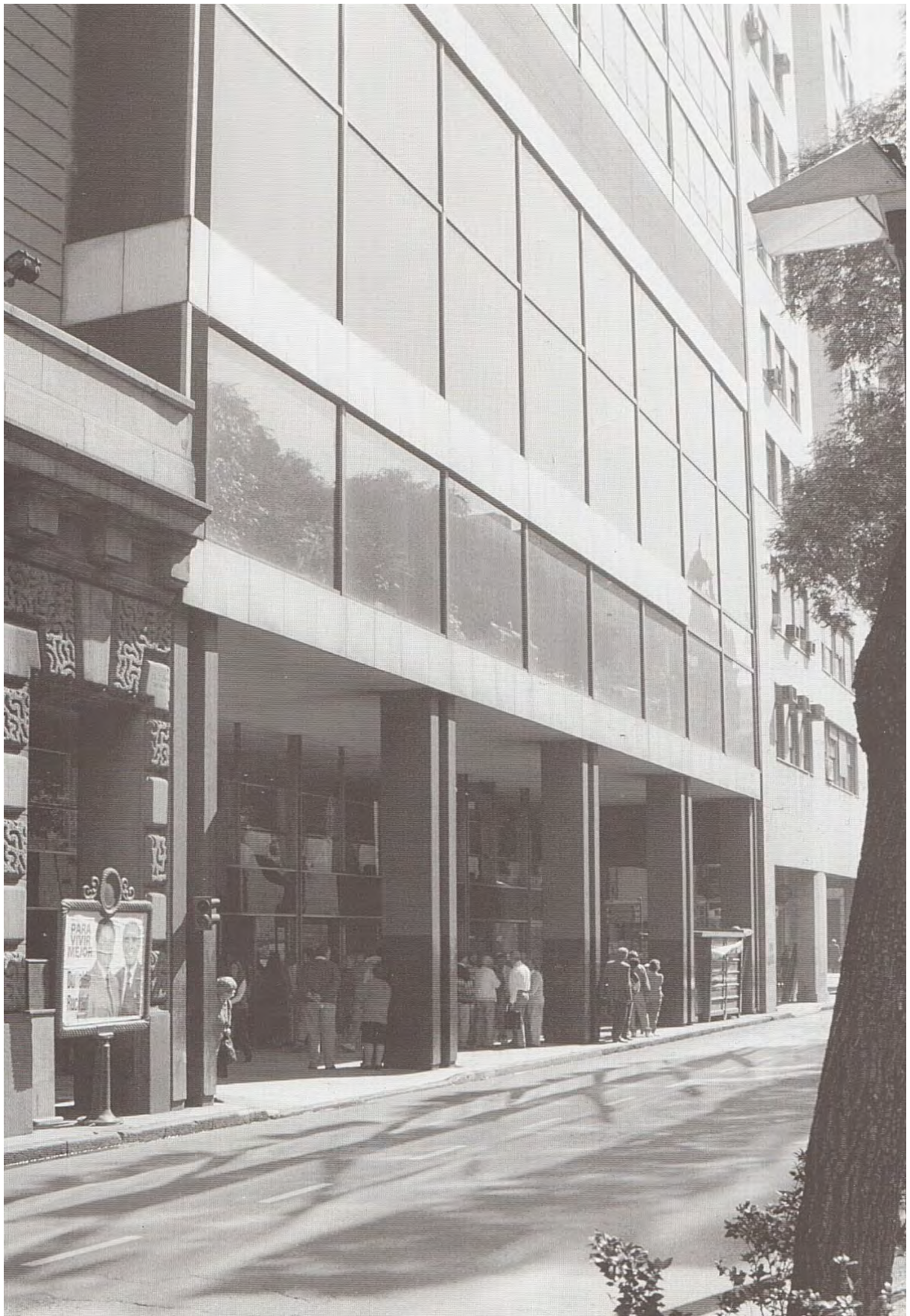
Fig. 144: Vista externa do pavimento térreo desde a Av. Leandro Alem, Bolsa de Comércio, 1972-1977.
