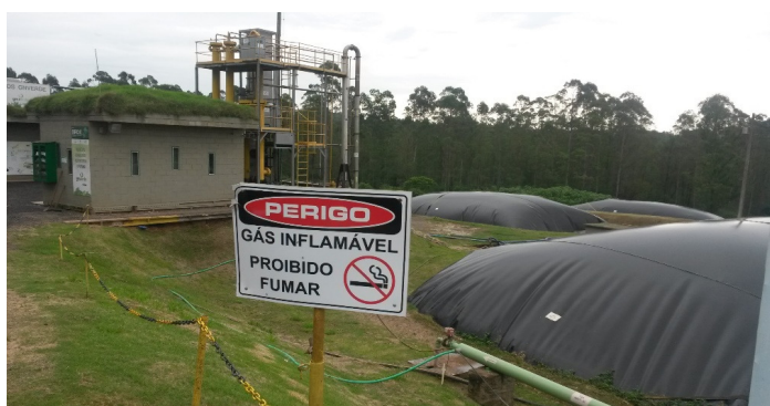
Figura 1. Usina de Compostagem e Biogás Ecocitrus (Consórcio Verde-Brasil).
