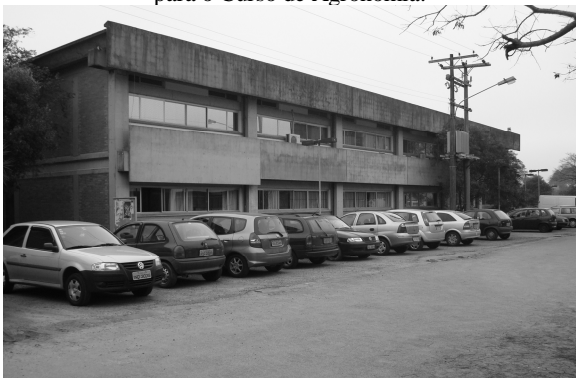
Vista do Prédio atual do Departamento de Geodésia, junto ao Campus do Vale da Agronomia.
