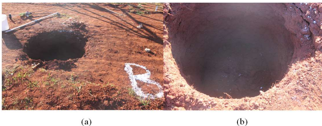
Figura 4.1: Cratera formada durante aplicação da técnica no presente trabalho: (a) vista geral da cratera (b) detalhe indicando pequeno aumento no diâmetro superior após a realização dos golpes
