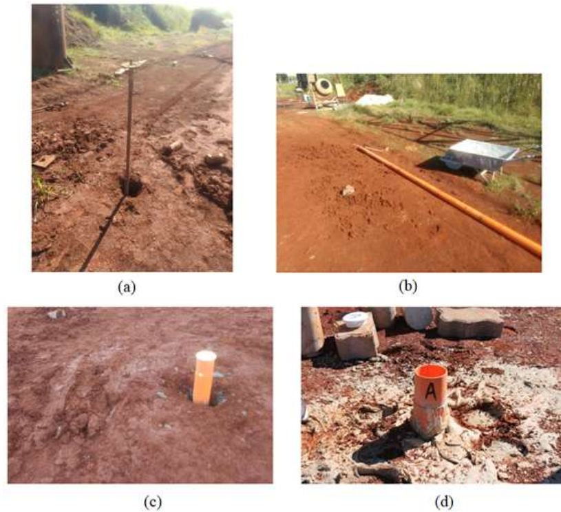
Figura 3.19: Instalação dos tubos de inclinômetros: (a) abertura dos furos com trado; (b) tubo de inclinômetro antes da instalação; (c) tubo posicionado dentro do furo; (d) tubo com a calda de cimento e bentonita
