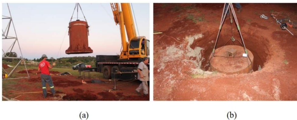
Figura 3.23: Compactação da camada de solo cimento (a) posicionamento do peso a uma altura de 3,0 m em relação ao solo; (b) peso dentro da cratera após a compactação
