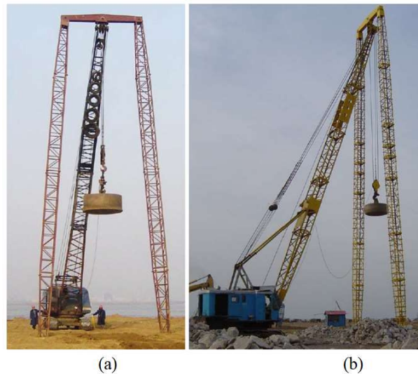
Figura 2.19: Guindastes adaptados com apoios, semelhantes a um tripé, usualmente utilizados na China (Hamidi, 2014)
