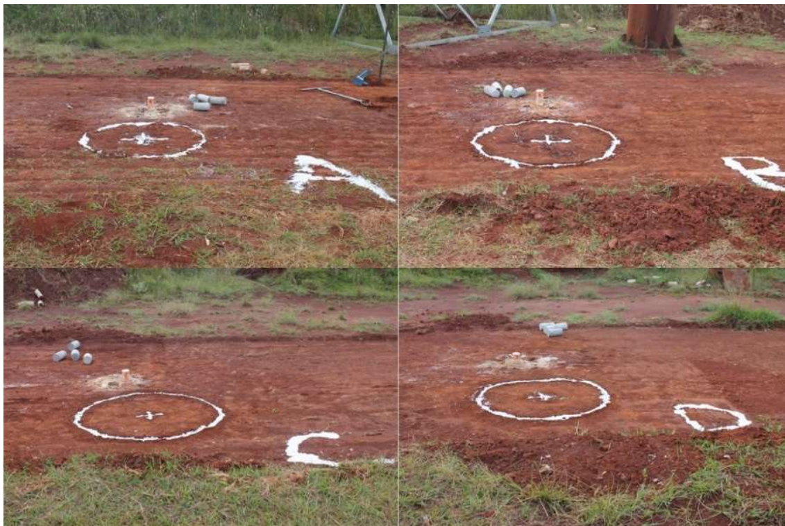
Figura 3.13: Detalhe de preparação do terreno para execução da compactação dinâmica
