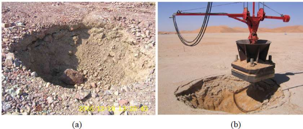
Figura 4.3: Representação do formatado de cratera em solos granulares: (a) compactação de um material granular (adaptado de Feng et al., 2011) (b) detalhe da cratera formada durante a compactação de um solo arenoso (adaptado de Hamidi, 2014)
