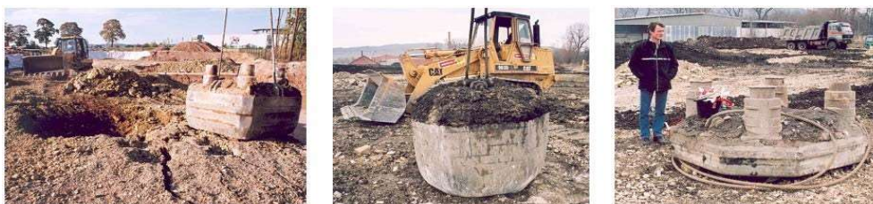
Figura 2.21: Tipo de pesos de queda (adaptado de Kopf, 2010)
