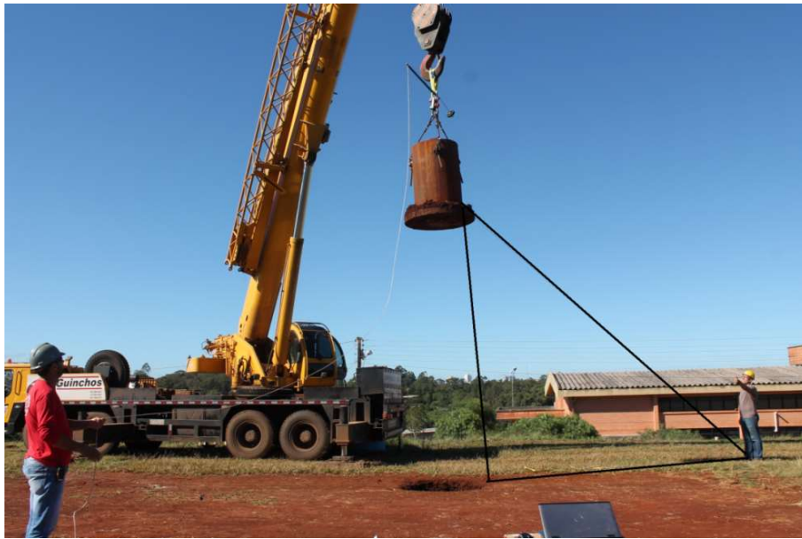
Figura 3.16: Peso de queda na posição para ser solto, a altura de queda foi controlada através de um triângulo, destacado na figura, que vai sendo modificado em função da profundidade da cratera
