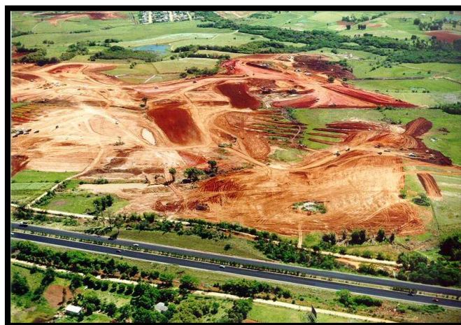
Fig. 129. Terraplenagem da GM em Gravataí
