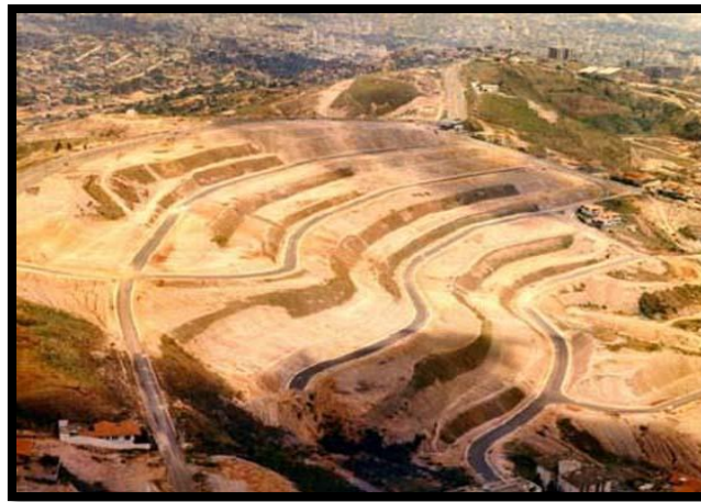
Fig. 131. Terraplenagem em degraus
