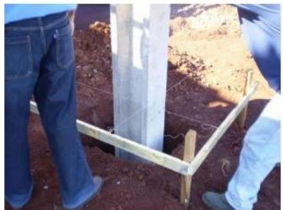
Fig. 93. Processo de locação de um pilar de uma obra.
