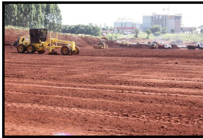
Fig. 128. Terraplenagem de uma área
