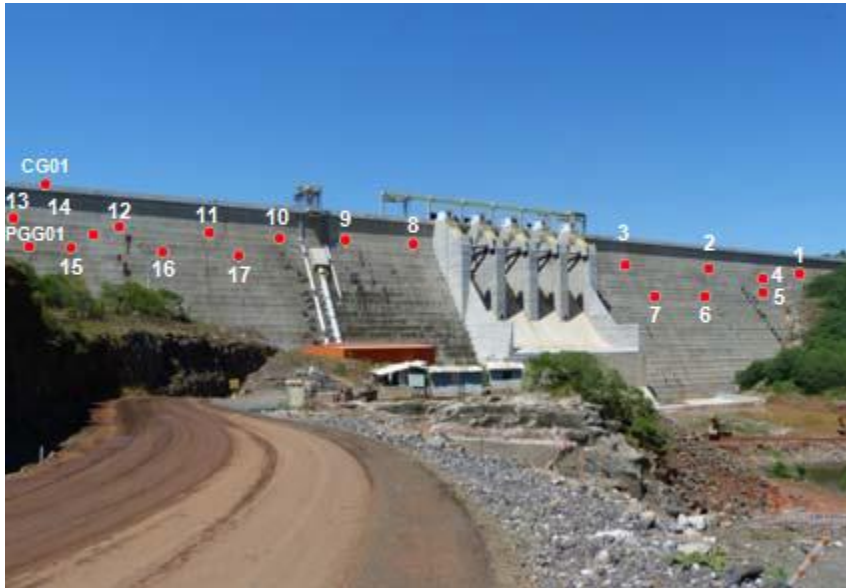
Fig. 72. Posição das miras na frente da barragem
