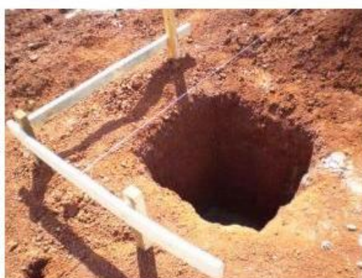
Fig. 93. Processo de locação de um pilar de uma obra.
