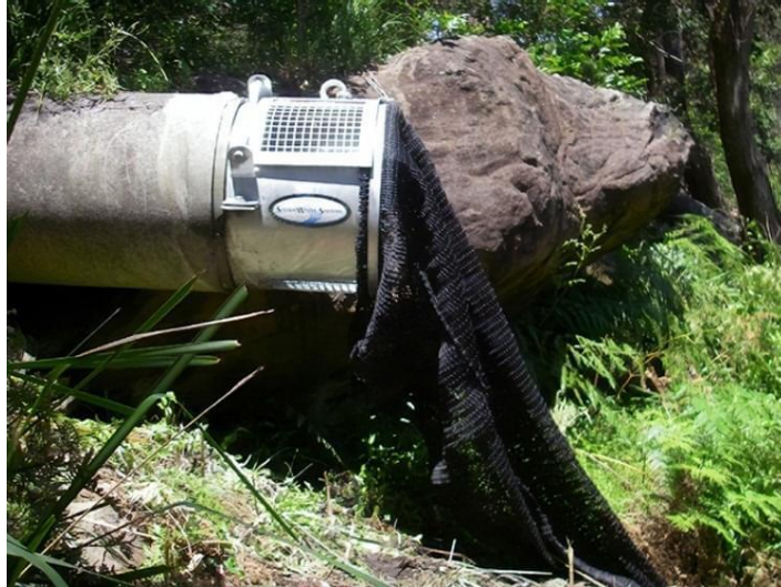
Figura 23 - Sistema projetado pela Storm Water Systems.
