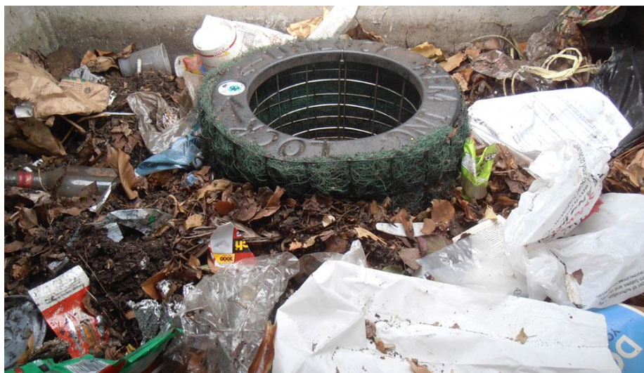
Figura 21 - Filtro Full Trash Capture (FTC) aplicado.
