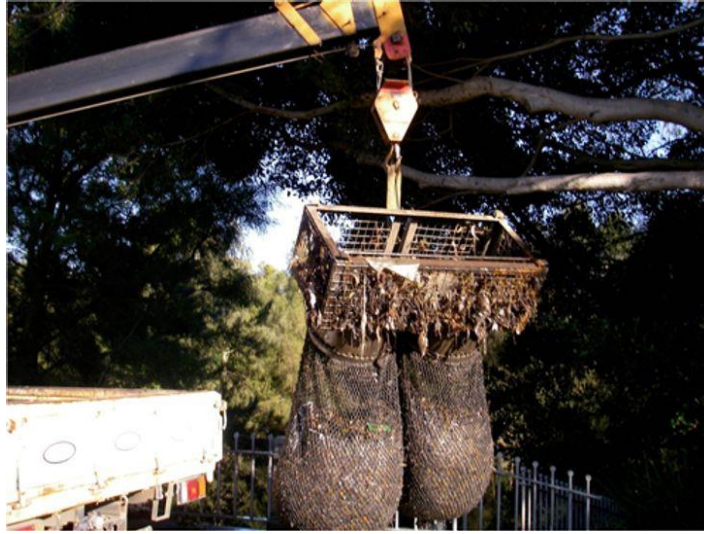
Figura 24 - Remoção das redes preenchidas por resíduos.
