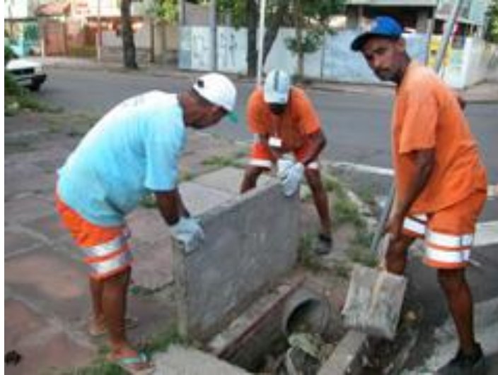
Figura 7 - Recuperação intensiva de bocas de lobo no município de Porto Alegre.
