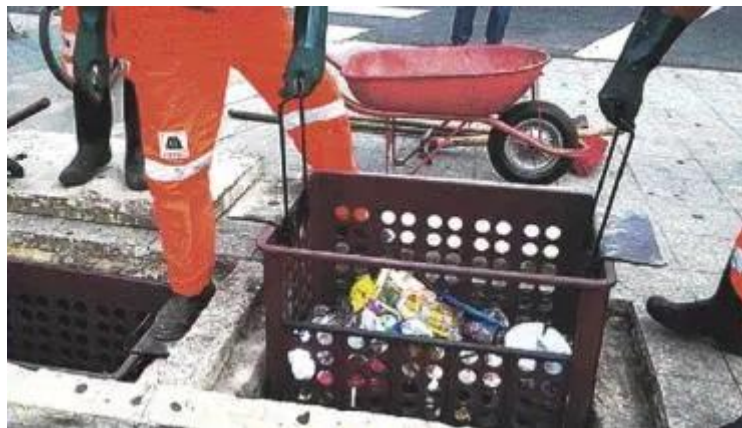
Figura 13 - Funcionários da prefeitura de São Paulo executando limpeza da caixa retentora de resíduos.
