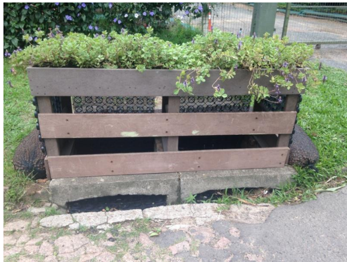
Figura 25 - Boca de lobo que foi licenciada para receber a armadilha projetada.
