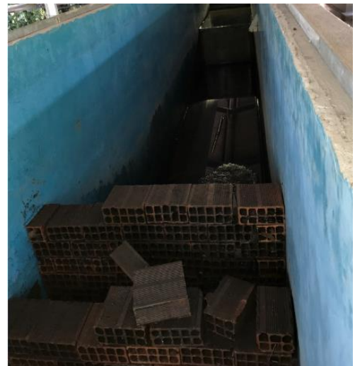
Figura 106 – montagem do sistema de tranquilização do escoamento.
