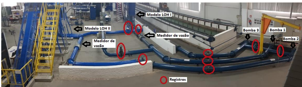
Figura 119 – Sistema de bombeamento do laboratório de obras hidráulicas.
