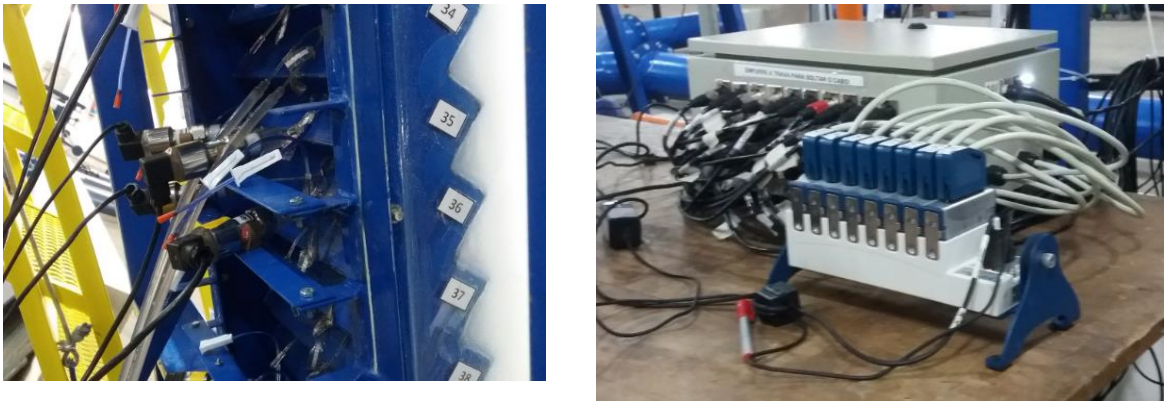
Figura 132 - Conexão dos transdutores na calha em degraus e caixa e sistema de aquisição utilizados
