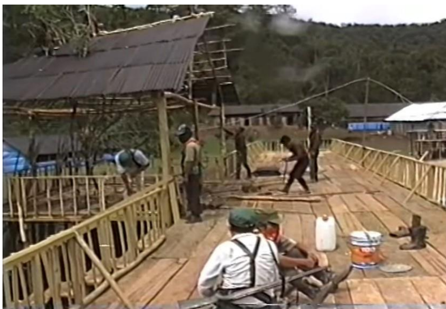
Figura 14 - Foto da construção do primeiro Aguascalientes, em Guadalupe Tepeyac, 1994.
