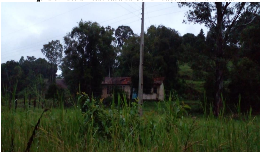
Figura 6: Escola Desativada da Comunidade de Barra Funda.
