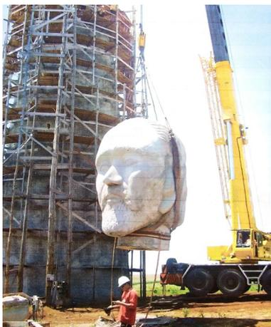
Figura 29 **Encaixe da cabeça do monumento ao corpo através de guindaste. A operação ocorreu em 9 de dezembro de 2006, às 12h45min.**
