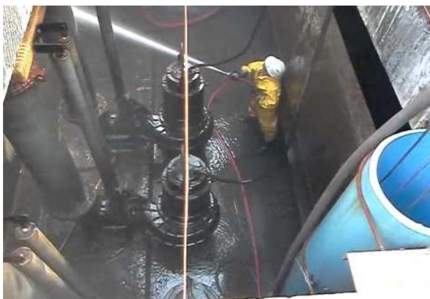
Figura 3 – Processo de limpeza de tanque de armazenamento de água produzida.
