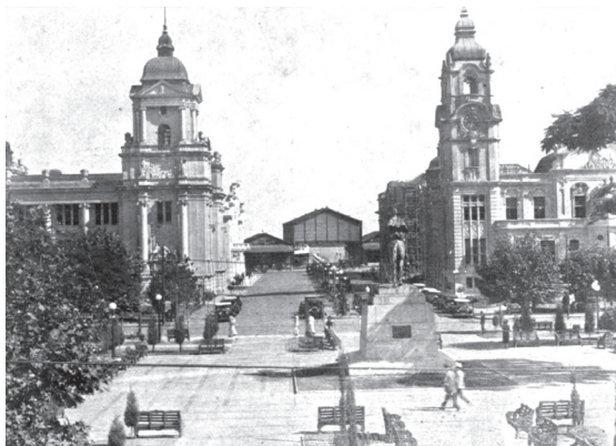
Figura 8- Praça da Alfândega e avenida Sepúlveda, 1922.
