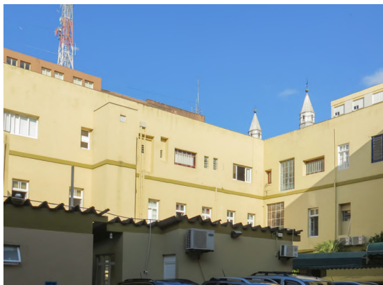
Figura 270- Vista através do pátio interno.
