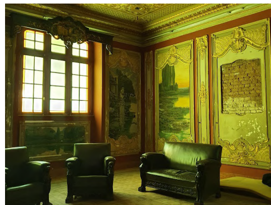
Figura 75- Em restauração: Gabinete do Presidente do Estado, 2022.
