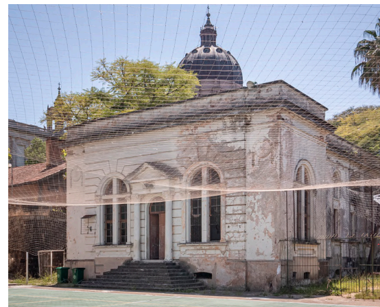
Figura 116- Pavilhão de ginástica.
