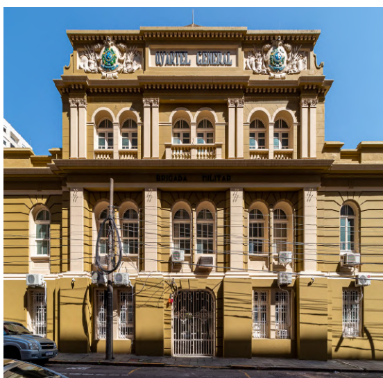
Figura 267- Fachada rua General Canabarro.
