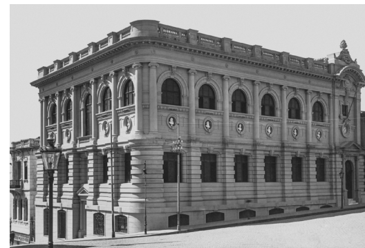
Figura 56- 2ª fase - obra concluída, 1922.
