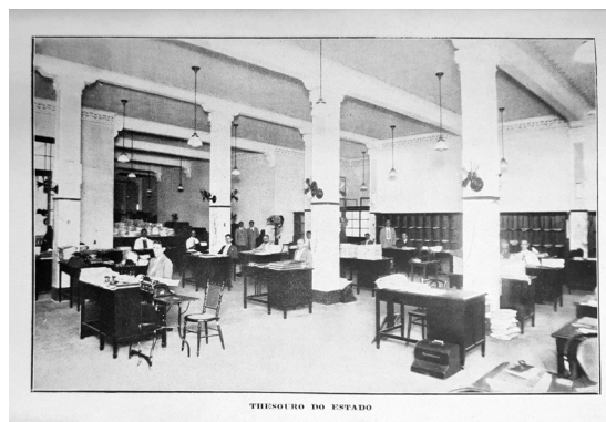
Figura 131- Imagem interna Tesouro do Estado.
