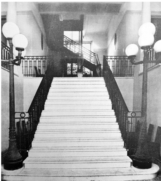
Figura 252- Escada do acesso principal, fotografia da época.
