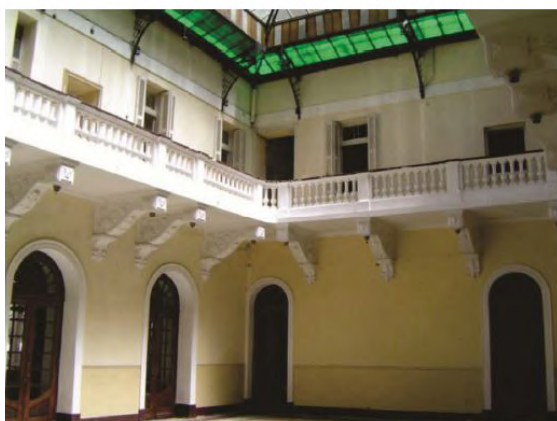
Figura 234- Átριο com cobertura de ferro e vidros coloridos, fotografia de 2003.
