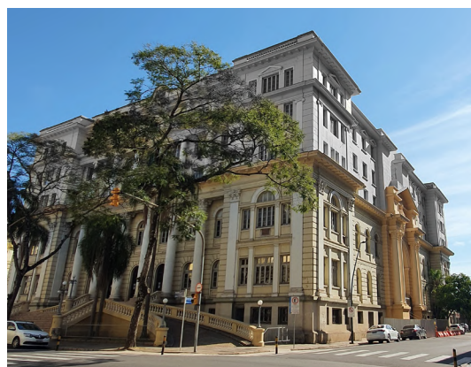
Figura 176- Conjunto de edifícios, 2021.
