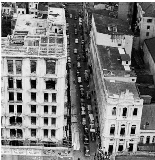
Figura 183- O Grande Hotel já desativado e o edifício A Federação.
