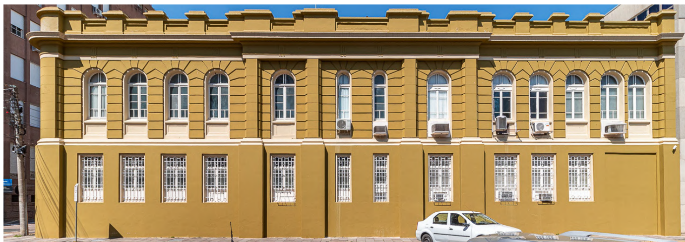
Figura 269- Fachada rua Sete de Setembro.
