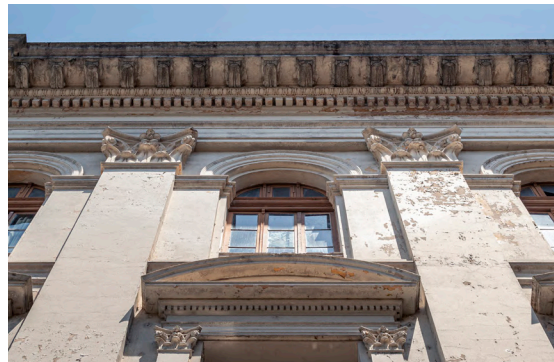
Figura 115- Trecho da fachada sul.
