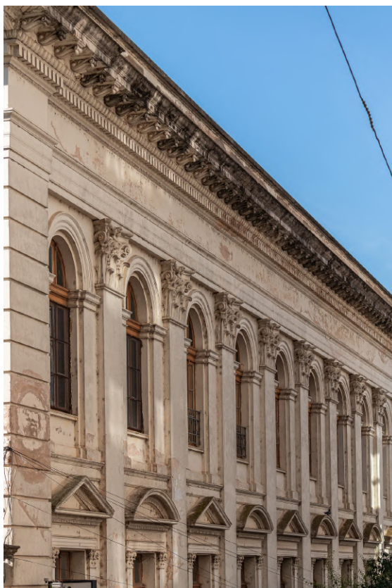
Figura 121- Fachada da rua General Auto composta por elementos clássicos.
