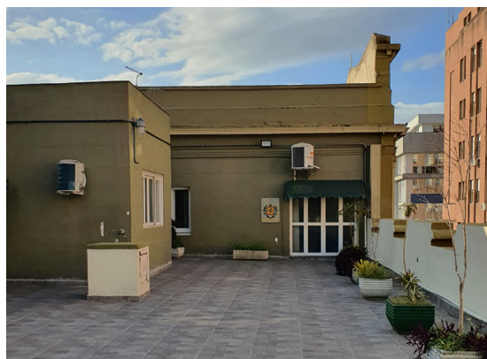
Figura 265- Terraço da cobertura.
