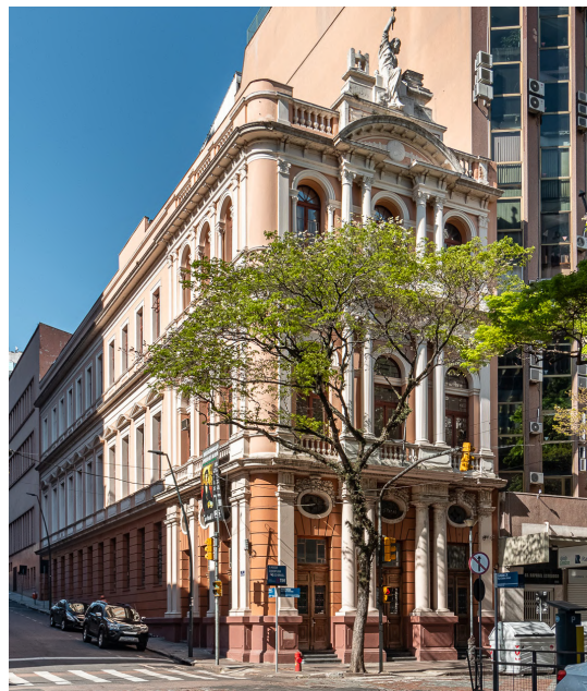
Figura 195- Vista da fachada principal e lateral.
