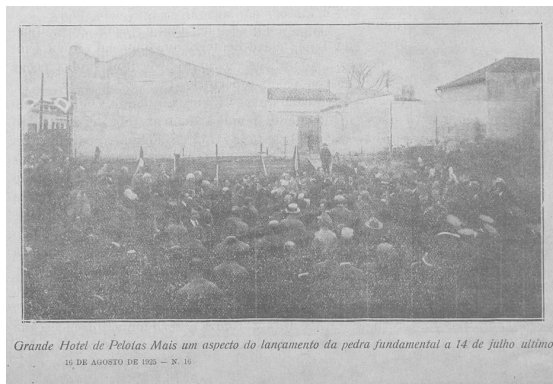
Figura 220- Lançamento da pedra fundamental da construção.
