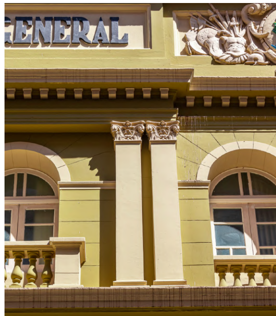
Figura 268- Detalhes do trecho da fachada aproximada.
