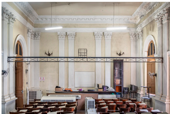
Figura 105- Auditório / sala de honra.
