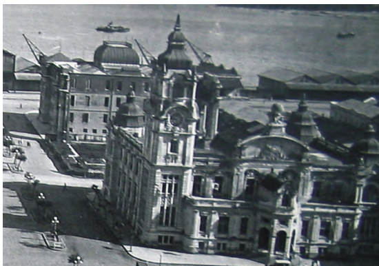
Figura 133- Edifício da Administração do Porto construído e edifício gêmeo em construção.
