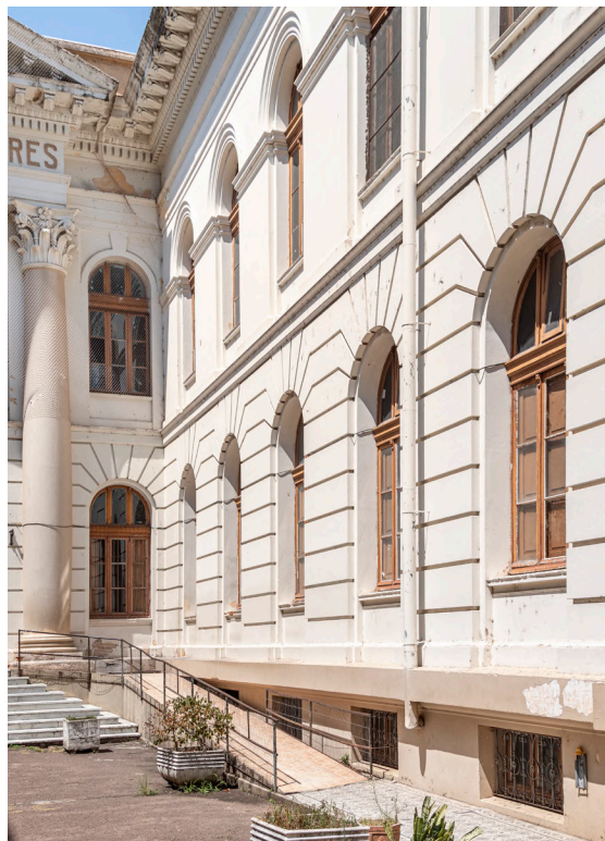
Figura 95- Rampa construída posteriormente.
