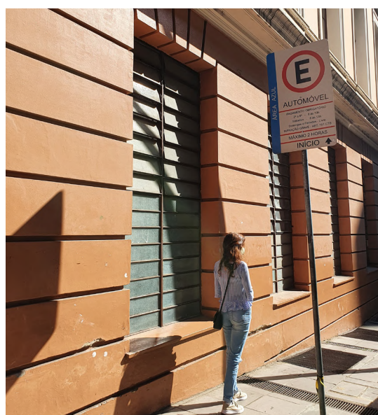
Figura 214- Passeio público com aberturas para iluminar o subsolo.
