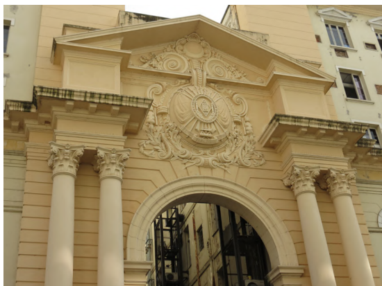
Figura 146- Pórtico voltado para a rua Cassiano do Nascimento.
