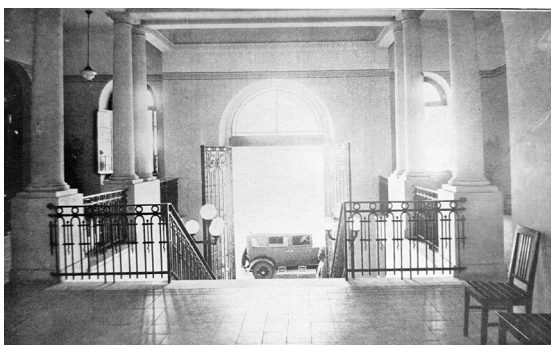
Figura 254- Vista interna do acesso.
