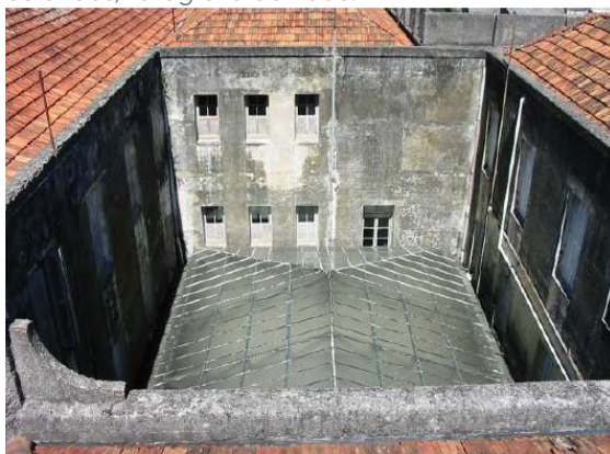
Figura 235- Vista superior do átριο, fotografia de 2003.
