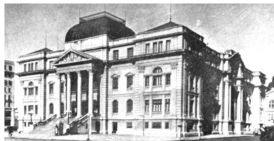
Figura 139- Em perspectiva o edifício voltado para a Av. Mauá.
