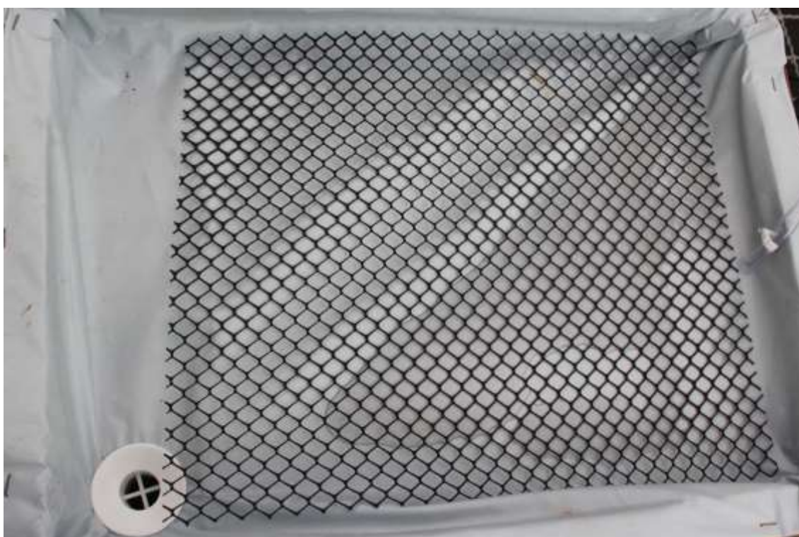
APÊNDICE 2: Detalhe da saída do drenado para recondução ao reservatório.
