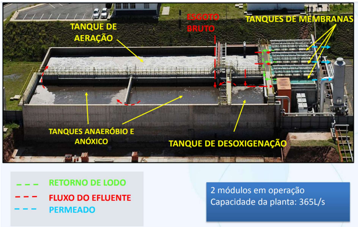
Figura 16 Módulo da EPAR Capivari II da SANASA em Campinas utilizando o sistema MBR
