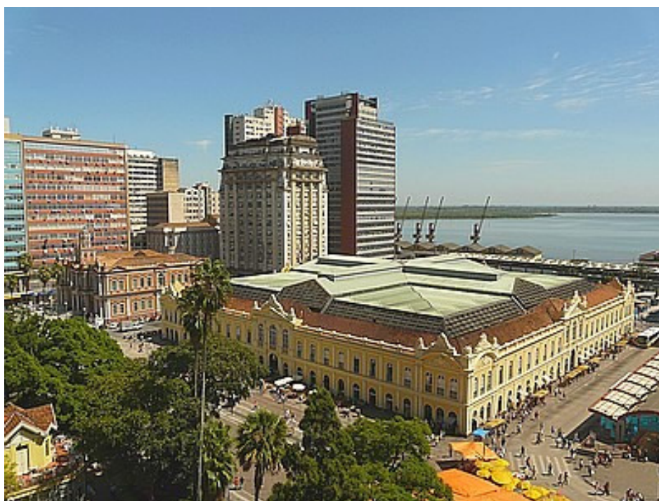
Foto 1. Mercado Público após a restauração, com a cobertura que integrou o primeiro e o segundo pavimento.
