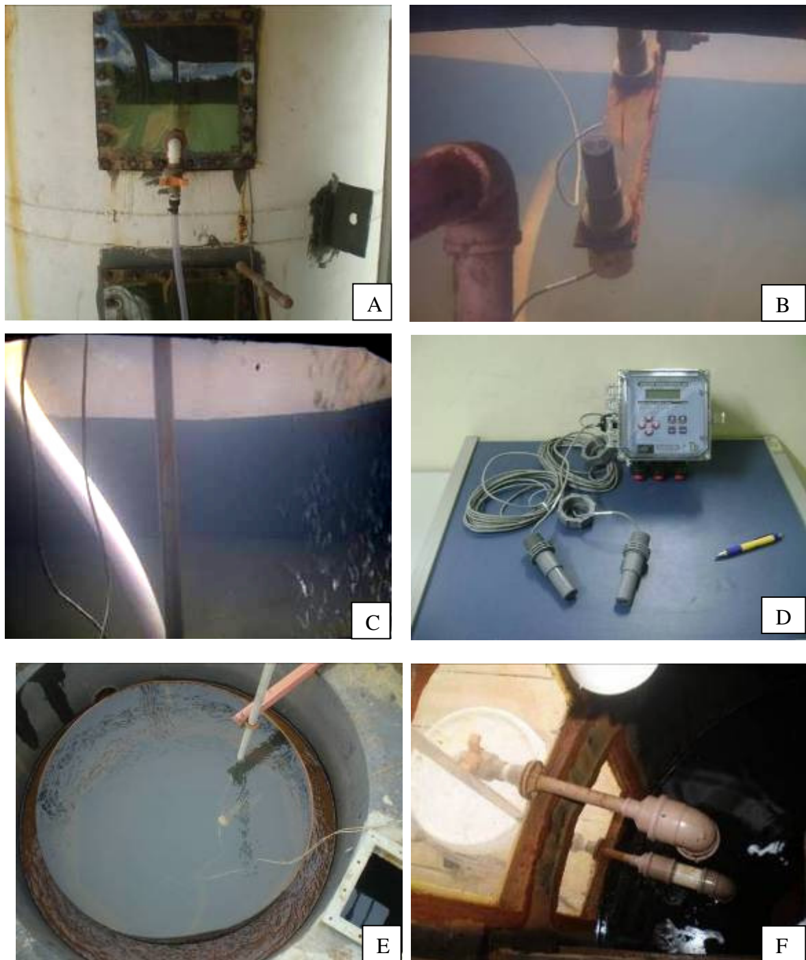
Figura 4.12 A: Ponto de aplicação do traçador, referente a abertura 3; B: Sondas de condutividade instaladas na abertura do decantador; C: Detalhe da passagem de bolhas da simulação do biogás; D: Controlador de condutividade; E: Indicação do ponto de fixação das sondas e canaleta de saída; F: Tubulações de aplicação do traçador.
