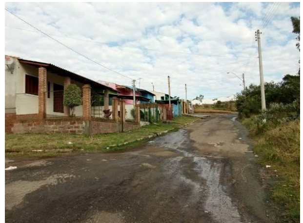
Figura nº 28 – Lot. São Tomé: esgoto escorrendo
