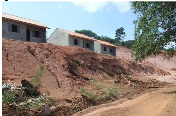
Figura nº 53 – Lot. Eldorado: casas acima do nível da rua
