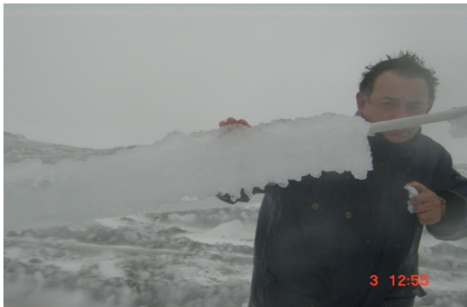
Figura 3.2: Camada de gelo envolvendo um condutor (CIGRÉ WG22).
