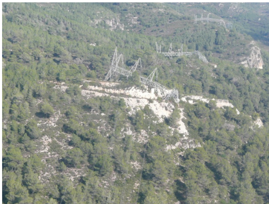
Figura 3.4: Cascata transversal na LT Rubí-Vandellós-Pierola de 400 kV na Espanha durante uma tempestade de 2008. (J.Santana López).
