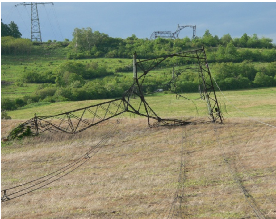
Figura 3.5: Cascata transversal de cinco torres de 400 kV devido a tempestade de Maio de 2006 na República Tcheca. (P. Froněk).
