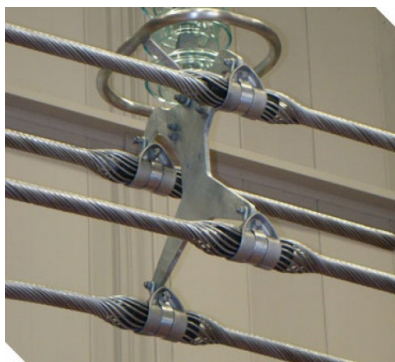
Figura 5.3: Espaçador quádruplo para condutores múltiplos.
