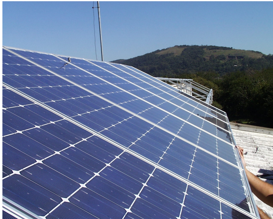
Figura E2. Instalação do sistema fotovoltaico do laboratório.
