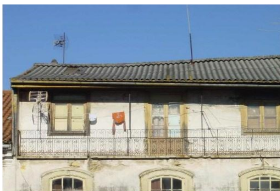
Figura 25: Fachada da edificação, Coimbra – Portugal (Viva Coimbra, 2007)
