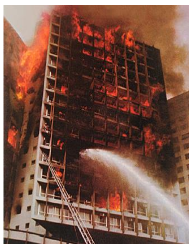
Figura 4: Incêndio no Edifício Joelma ( the-rioblog.blogspot.com.br )
