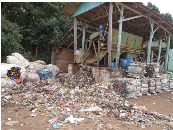
Figura 26. Recuperação da área do antigo lixão (a) Remoção de materiais não degradados por peneiramento e (b) composto orgânico pronto para uso Data: 27/03/13. Fonte: Acervo autora
