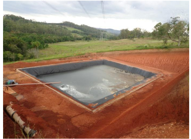
Figura 25. (a) Aterro para rejeitos de RSU do município de Campo Bom. (b) Lagoa para estabilização do chorume Data: 27/03/13. Fonte: Acervo autora
