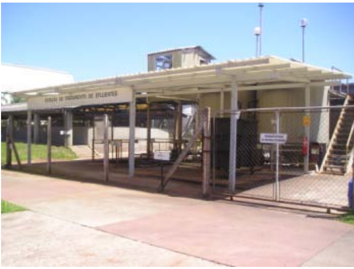
Figura 14. Foto geral da Estação de Tratamento de Efluentes
