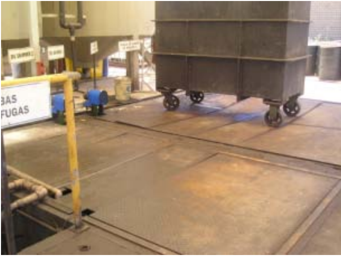
Figura 16. Tanque de acumulação.
