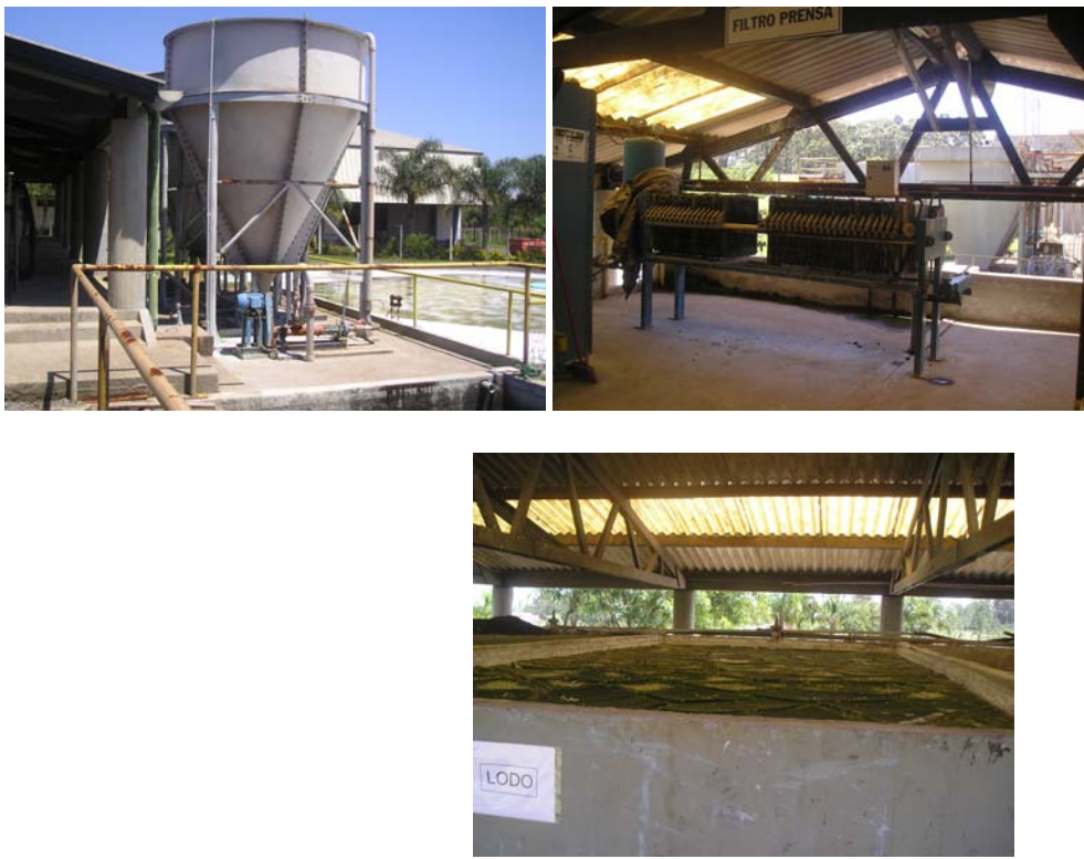
Figura 23. Adensadores, filtro-prensa e leito de secagem.
