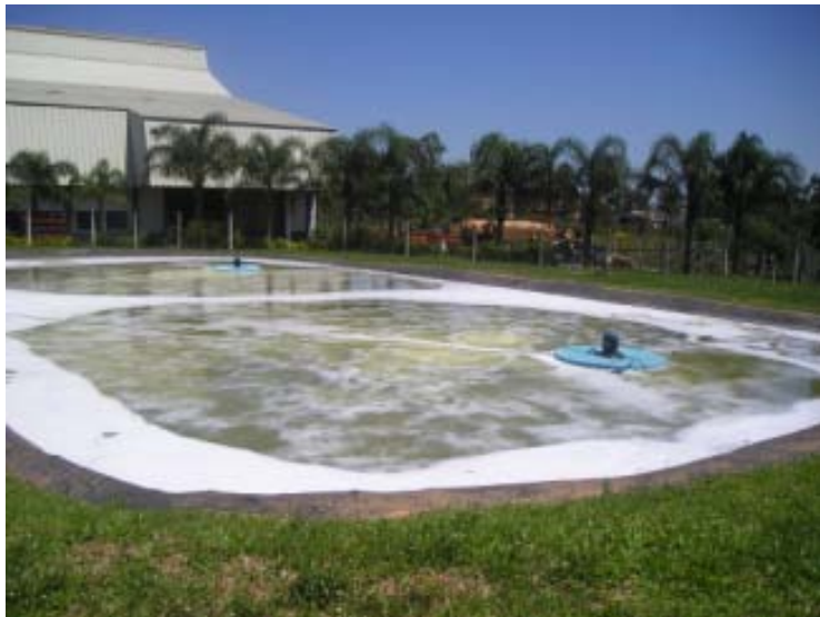
Figura 22. Lagoa aerada facultativa.
