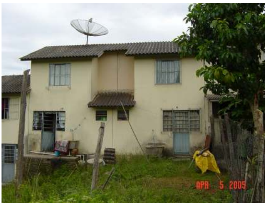
Figura 24: fachada de fundos original para um módulo de dois sobrados geminados
