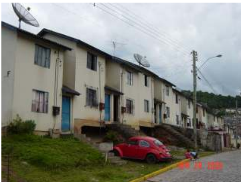
Figura 21: vista geral de um bloco de sobrados edificadas de forma geminada
