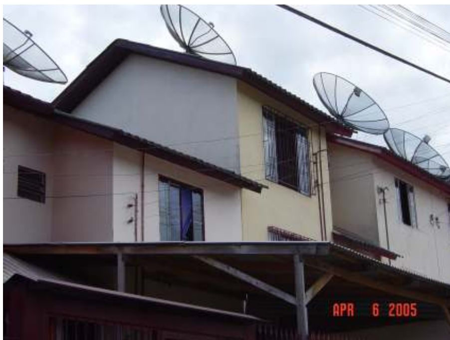
Figura 26: módulos subsequentes de dois sobrados geminados edificadas em cotas de construção diferentes
