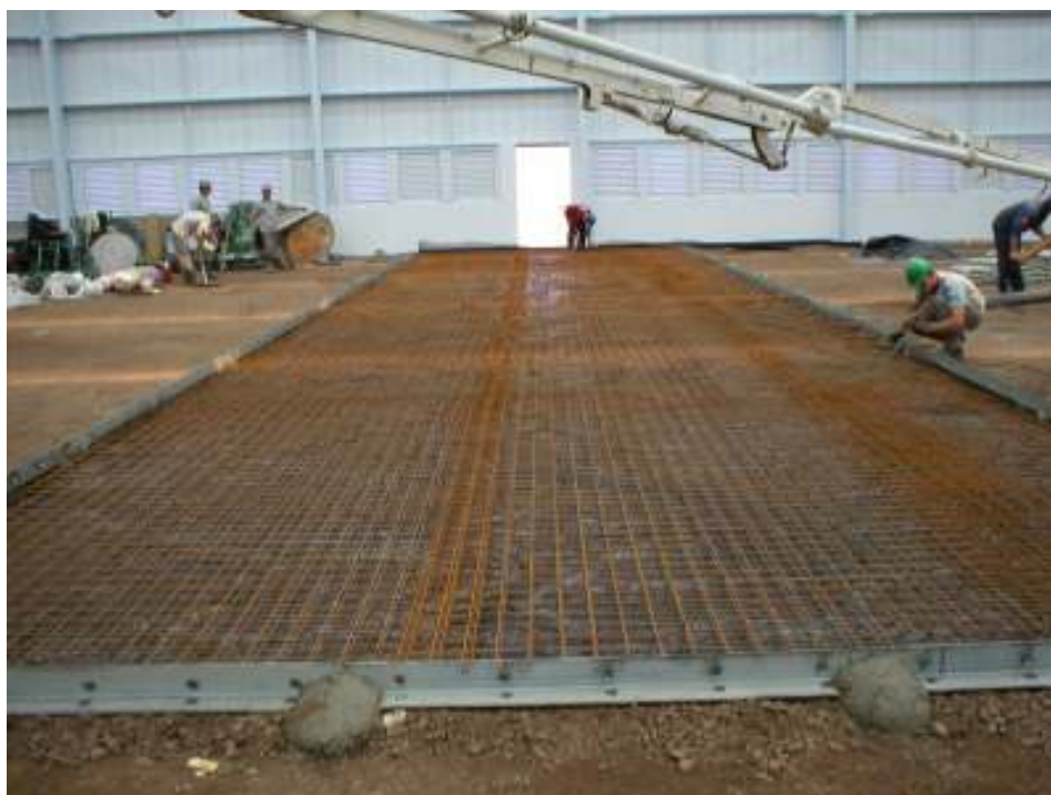
Figura 9: piso de concreto estruturalmente armado
