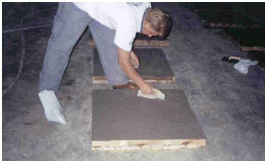
Figura 39: regularização da superfície com desempenadeira de madeira
