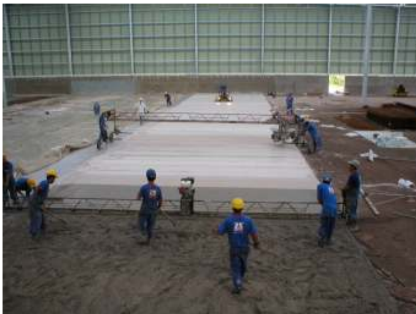
Figura 5: execução de piso de concreto estruturalmente armado
