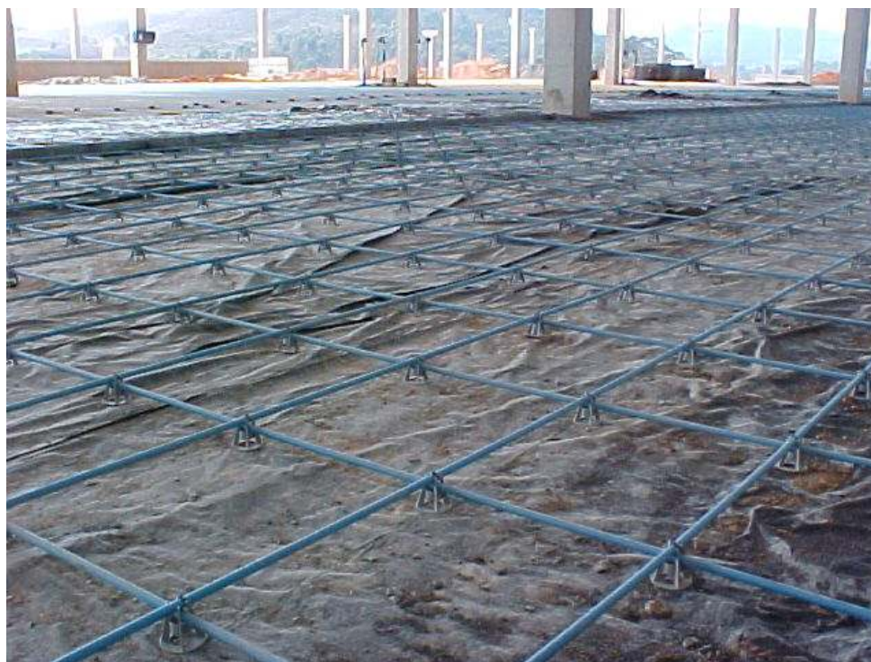
Figura 11: piso de concreto protendido
