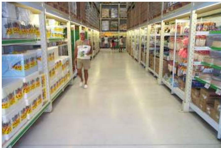
Figura 25: utilização de endurecedor cimentício colorido em supermercado
