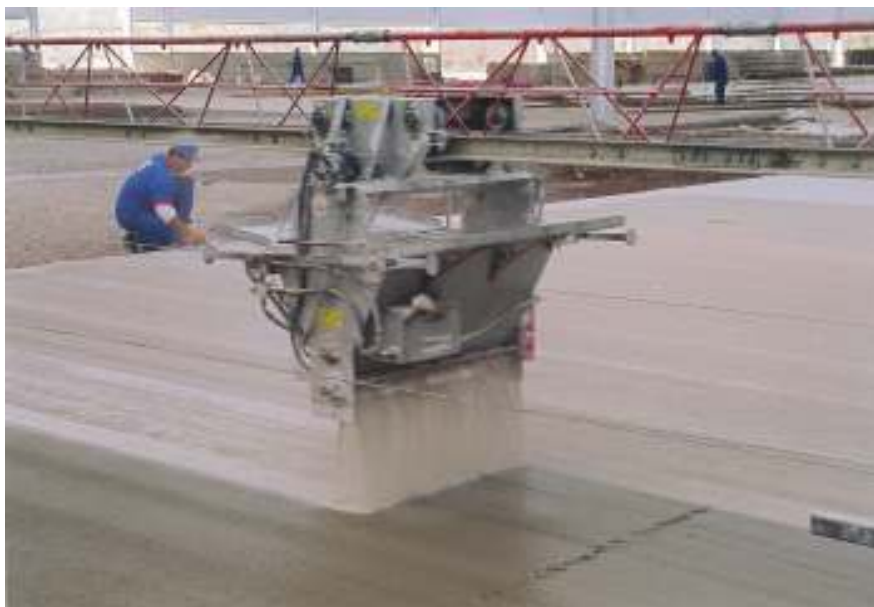
Figura 23: aplicação mecânica do endurecedor cimentício
