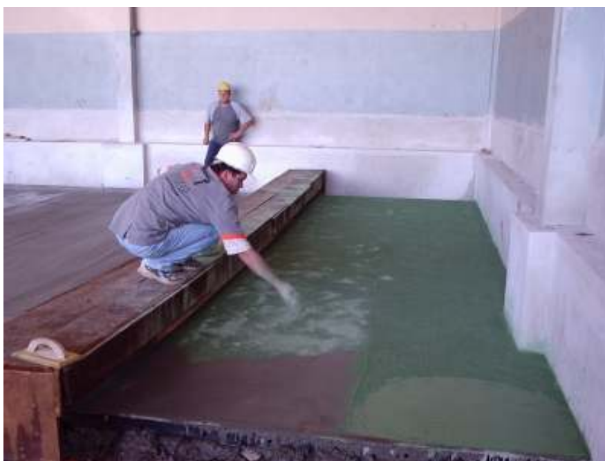
Figura 22: aplicação manual do endurecedor cimentício
