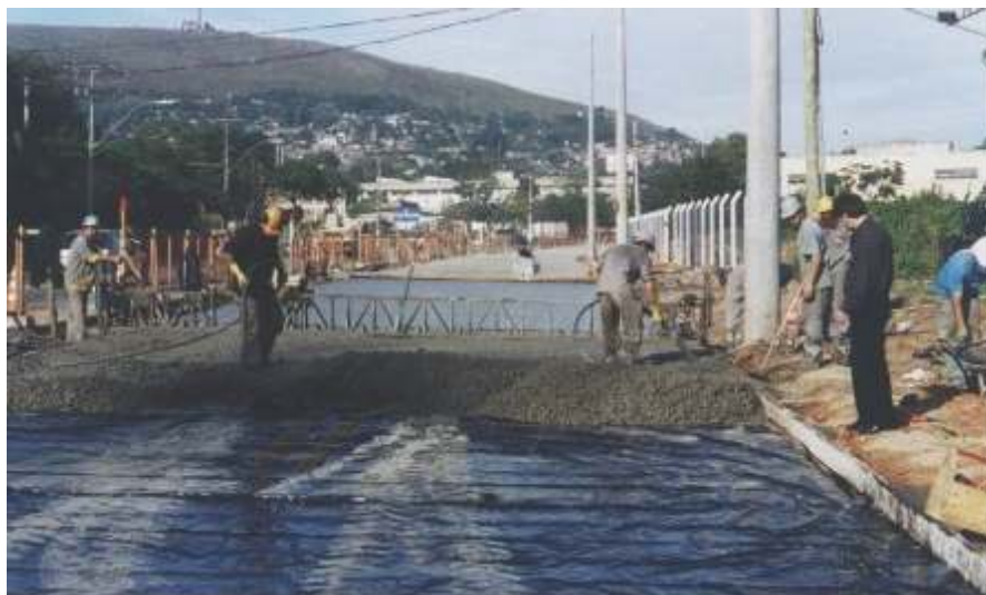
Figura 7: execução de pavimento em concreto simples na 3ª Perimetral em Porto Alegre/RS
