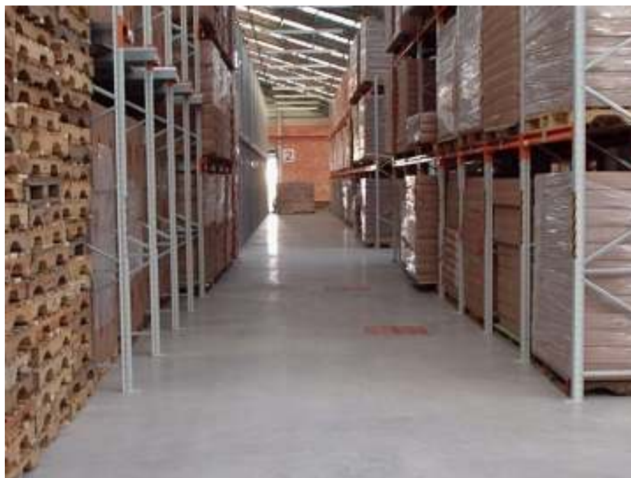
Figura 26: aplicação típica de endurecedor cimentício em centros de distribuição
