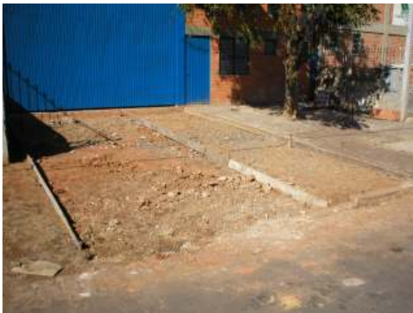
Figura 1: piso de concreto simples: preparo da base para execução da concretagem
