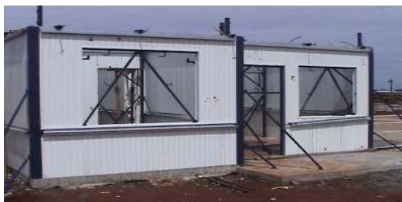
Figura 41: Montagem do sistema “A”
