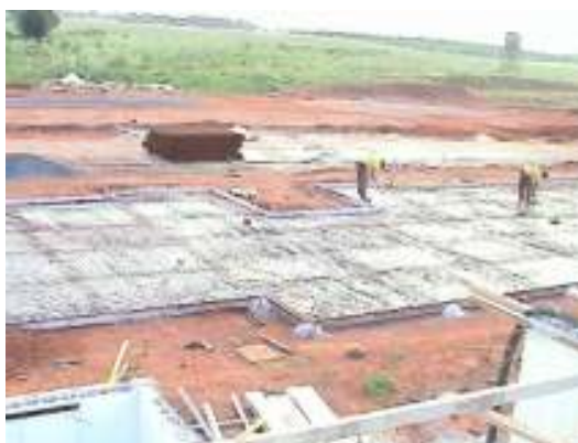
Figura 42: Fundação com radier
