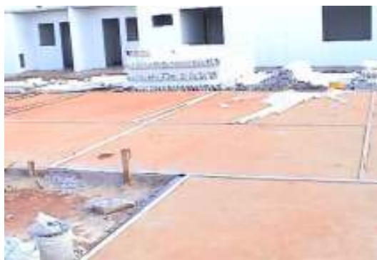
Figura 44: Perfil base já fixado
