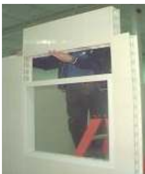
Figura 69: Montagem da janela em PVC
