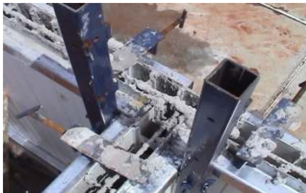
Figura 48: Junção de paredes
