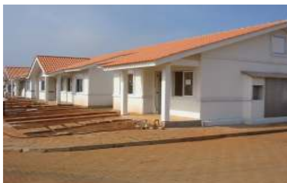
Figura 50: Vista geral do sistema de cobertura
