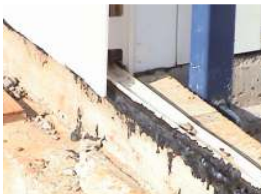
Figura 45: Impermeabilização na base do perfil
