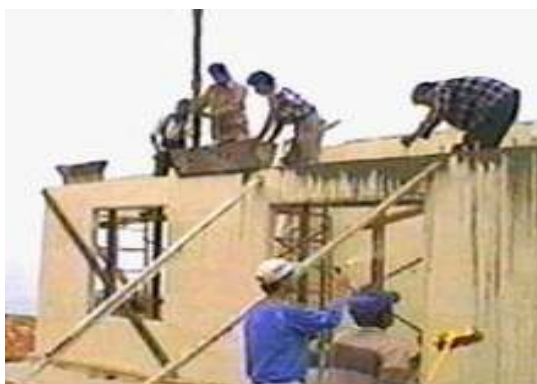
Figura 65: Concretagem das paredes de PVC
