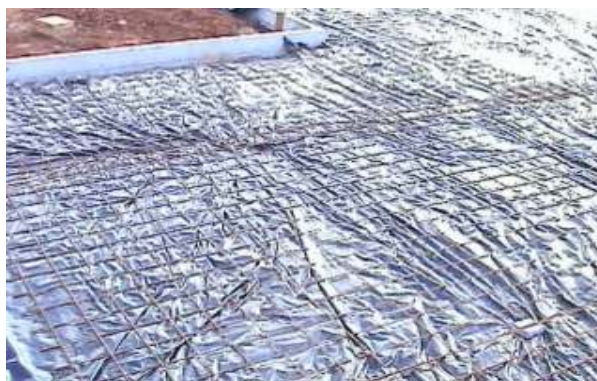
Figura 62: Armadura para radier
