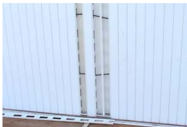
Figura 49: Barras de reforço
