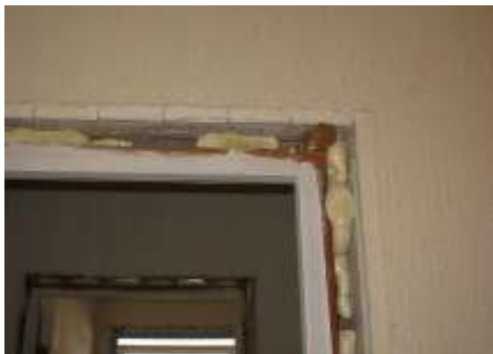
Figura 51: Fixação de porta
