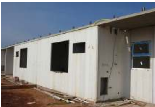
Figura 67: Laje de concreto na cobertura
