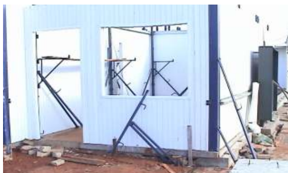
Figura 46: Montagem a partir do vértice
