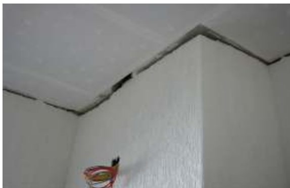
Figura 53: Revestimento de textura acrílica
