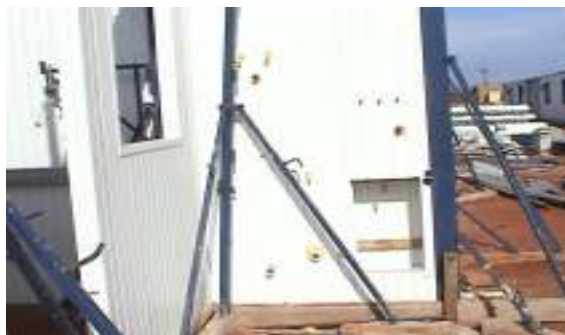
Figura 55: Instalações hidráulicas com “shaft”
