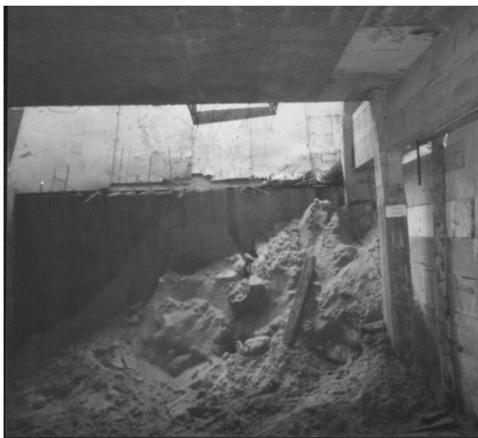
Figura 34: estocagem do agregado miúdo na obra 1
