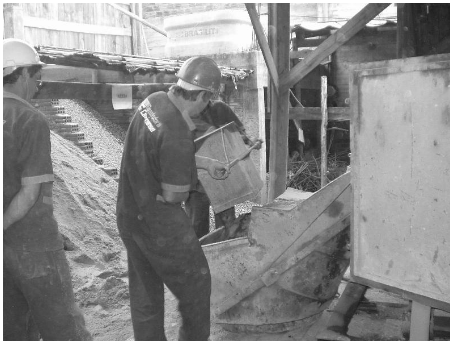
Figura 44: colocação de padiolas de agregados no carregador da betoneira.
