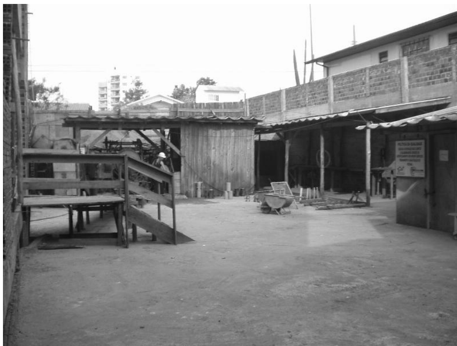
Figura 43: vista do local de produção de concreto na obra 2, com depósito de cimento à direita, e baias de agregados ao fundo.
