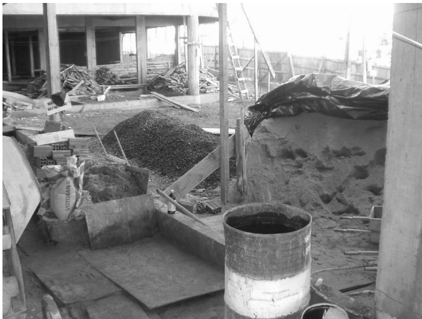
Figura 50: forma de estocagem dos agregados na obra 3
