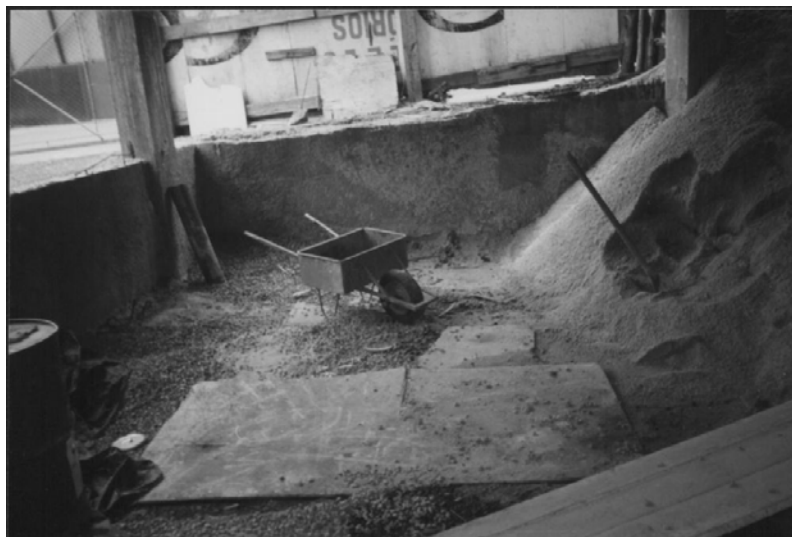
Figura 33: carrinho padiola para dosagem concreto
