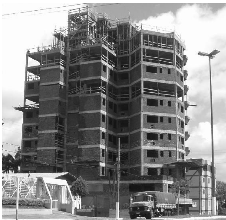
Figura 41: vista da obra 2.
