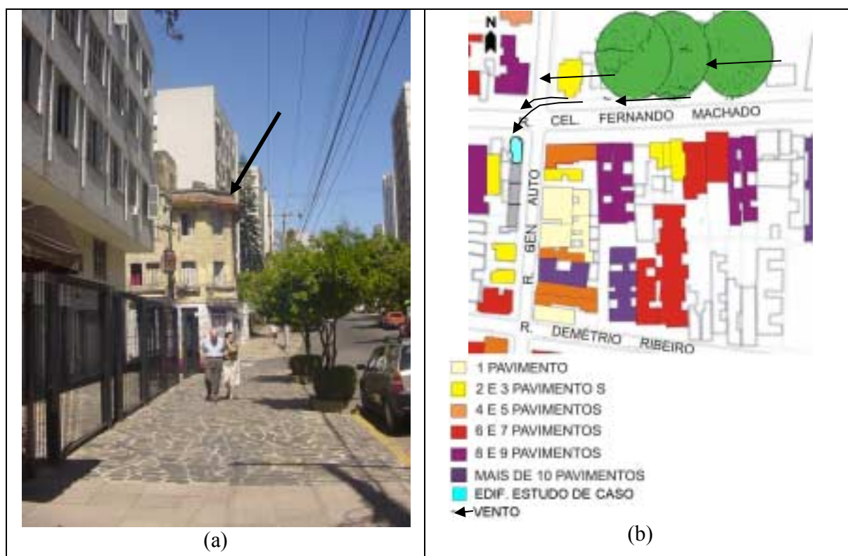
Figura 86: (a) fachada voltada para Rua General Auto, esquina Rua Fernando Machado – edificação A; (b) mapa localização da edificação.
