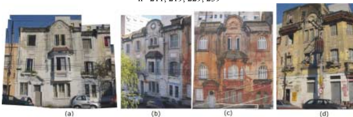
Figura 55: vista frontal das fachadas das 04 edificações em análise, Rua General Auto nos (a) 239, (b) 229, (c) 219, (d) 211.
