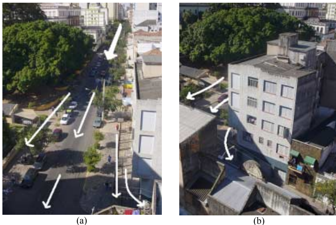
(a) (b) Figura 66: direcionamento do escoamento de vento, (a) sentido leste-oeste escoamento Rua Fernando Machado; (b) sentido leste-oeste escoamento Rua Fernando Machado, obstrução parcial do escoamento edificações Rua Gen. Auto
