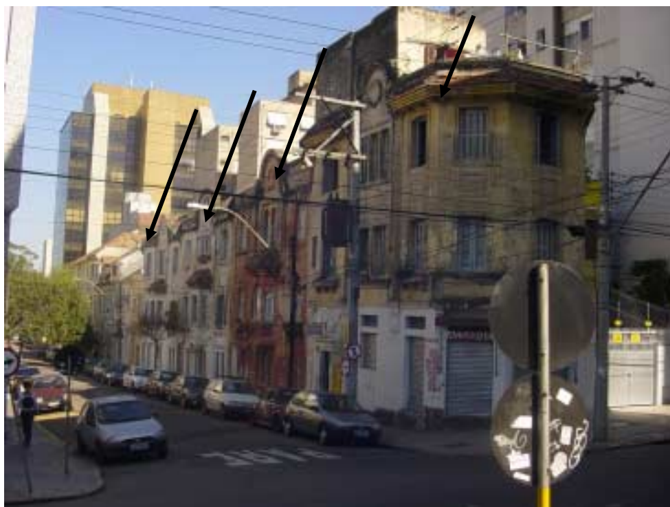
Figura 54: edificações em análise, Rua General Auto n os 211, 219, 229, 239
