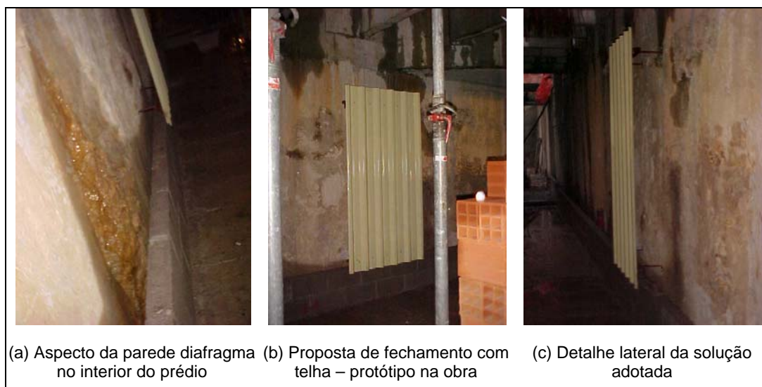
Figura 48: protótipo para fechamento da parede diafragma
