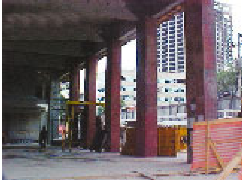
Figura 13: Vista geral do pilares do Edifício E- Tower /SP
