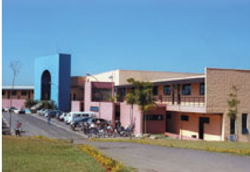
Figura 3: Vista da fachada da Prefeitura de Indaiatuba/SP
