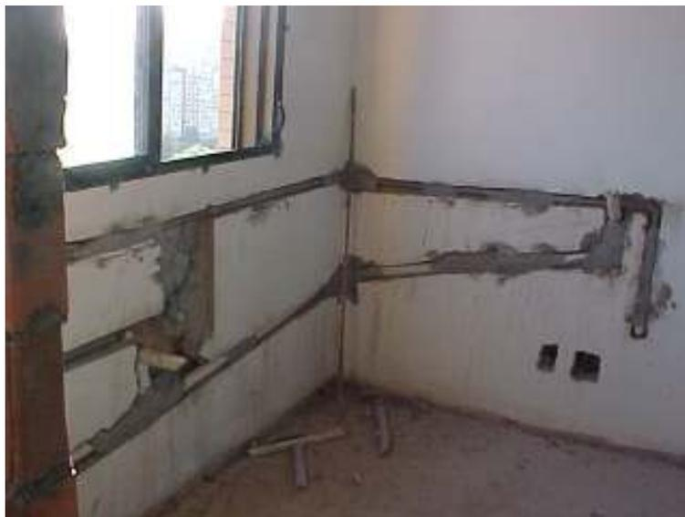
Figura 57: apartamento 1201- inclusão de instalações hidráulicas na dependência de empregada, transformada em serviço
