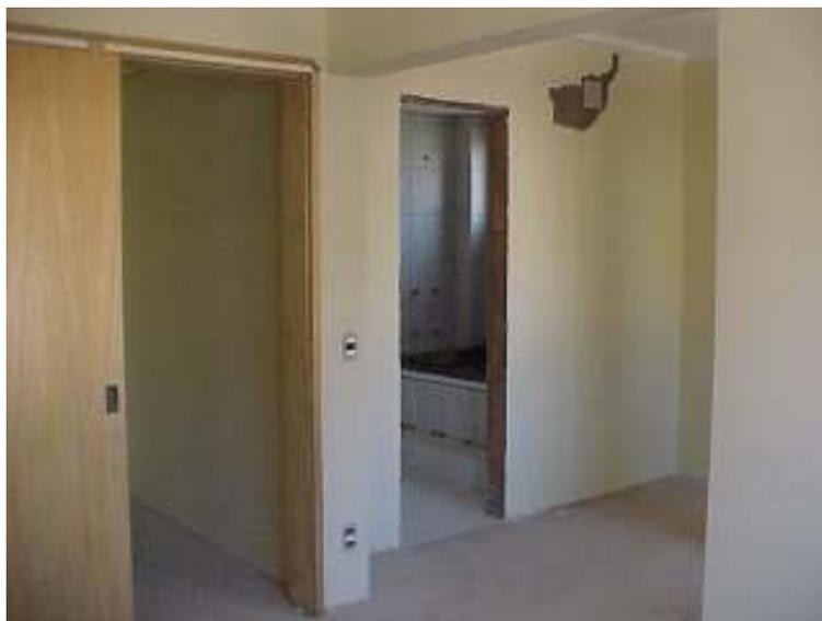
Figura 27: apartamento 601 - aberturas para instalações de espera para o ar condicionado
