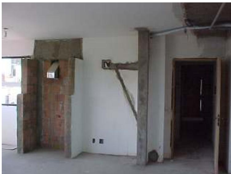
Figura 43: apartamento 902 - alteração instalação de ar condicionado
