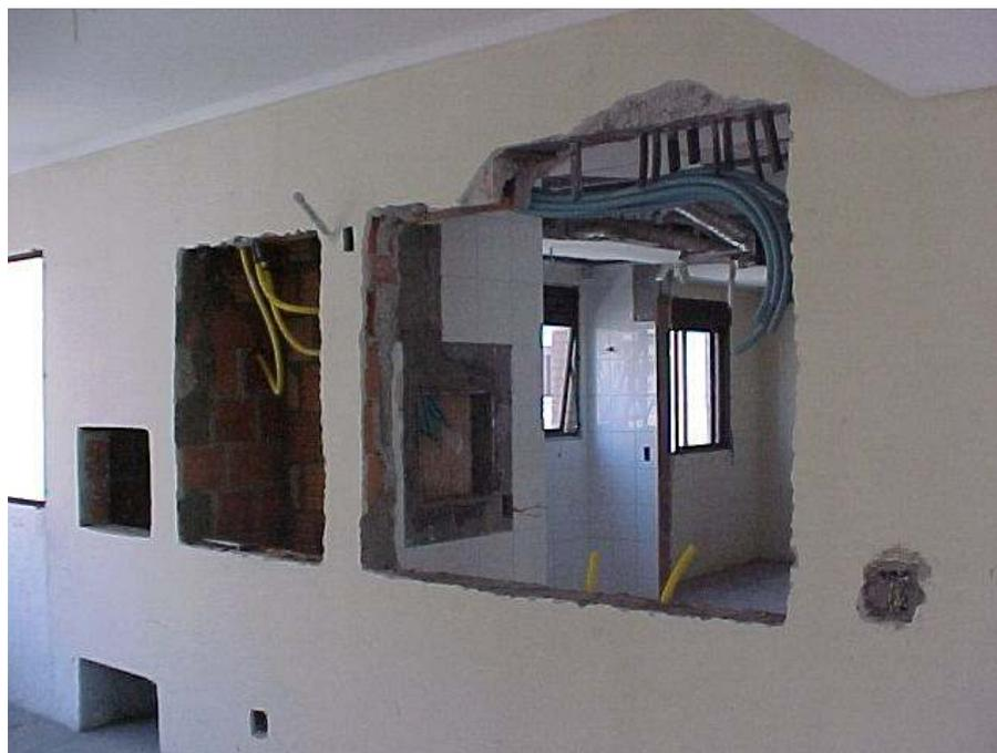
Figura 16: abertura de vão e demolição parcial da viga, apartamento 301
