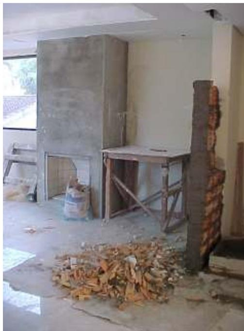
Figura 12: apartamento 202- execução de lareira e alteração de localização de parede
