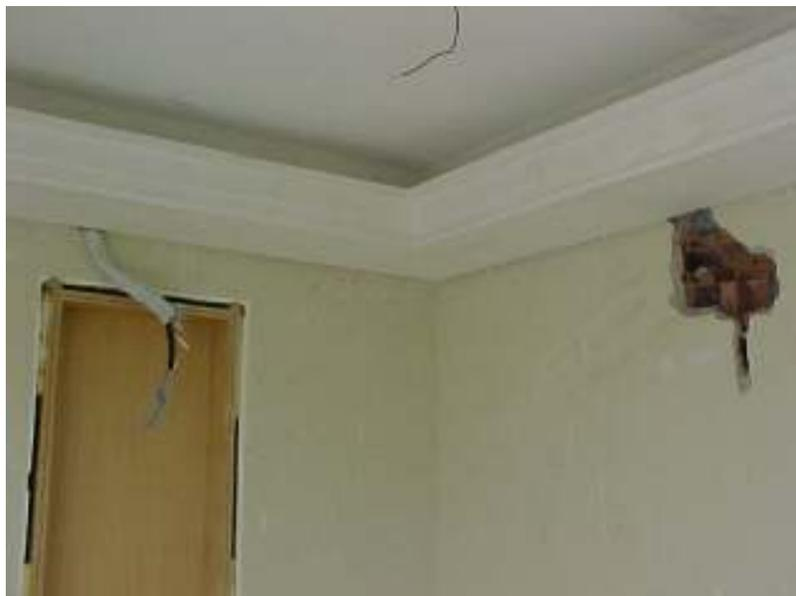
Figura 13: apartamento 202- modificação da especificação e posição do aparelho de ar condicionado.
