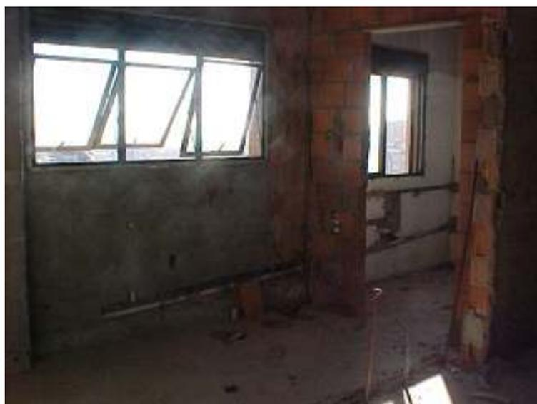
Figura 56: apartamento 1201- paredes refeitas e canalizações aparentes, devido à retirada das paredes
