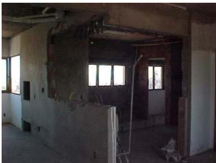
Figura 58: apartamento 1201- demolição de paredes, para integração de ambientes
