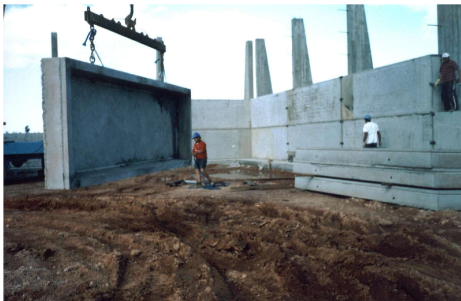
Mostra um Painel Pré-Moldado em Concreto Armado de 1,75 x 5,50m (2000)
