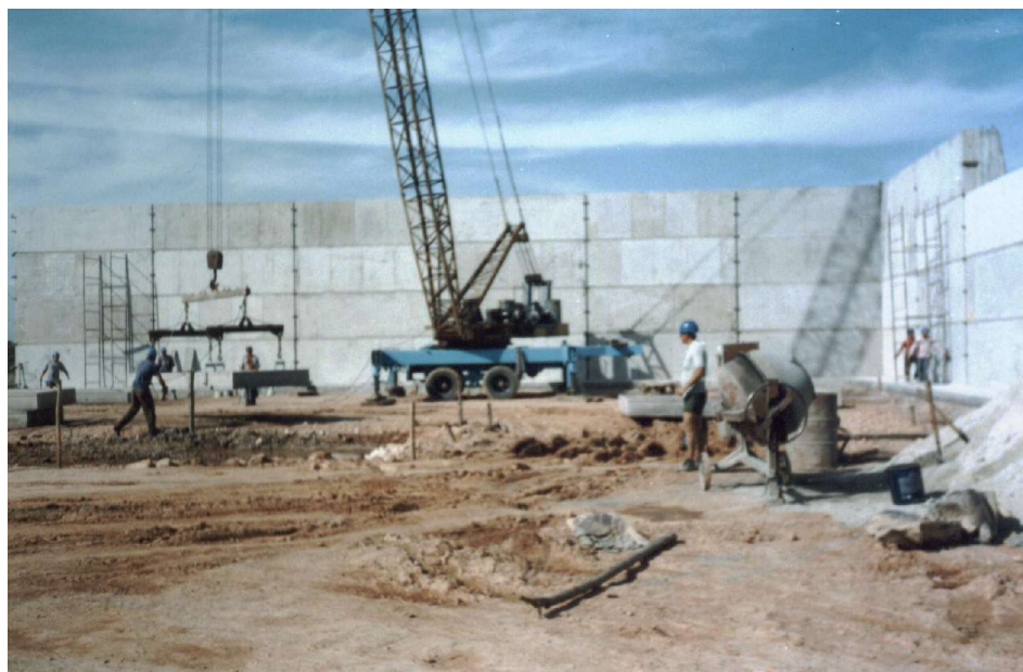
Mostra vários painéis parafusados nos pilares (2000)
