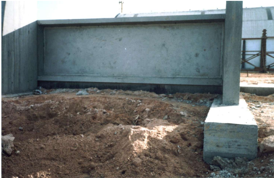
Mostra a vista externa de um painel (2000)
