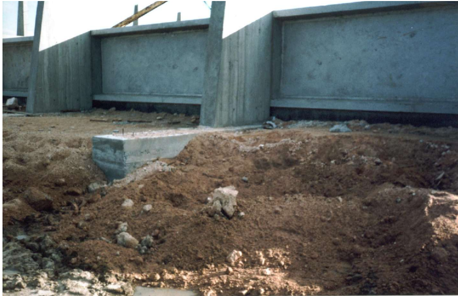
Mostra o Painel inferior, o pilar engastado no bloco de fundação.
