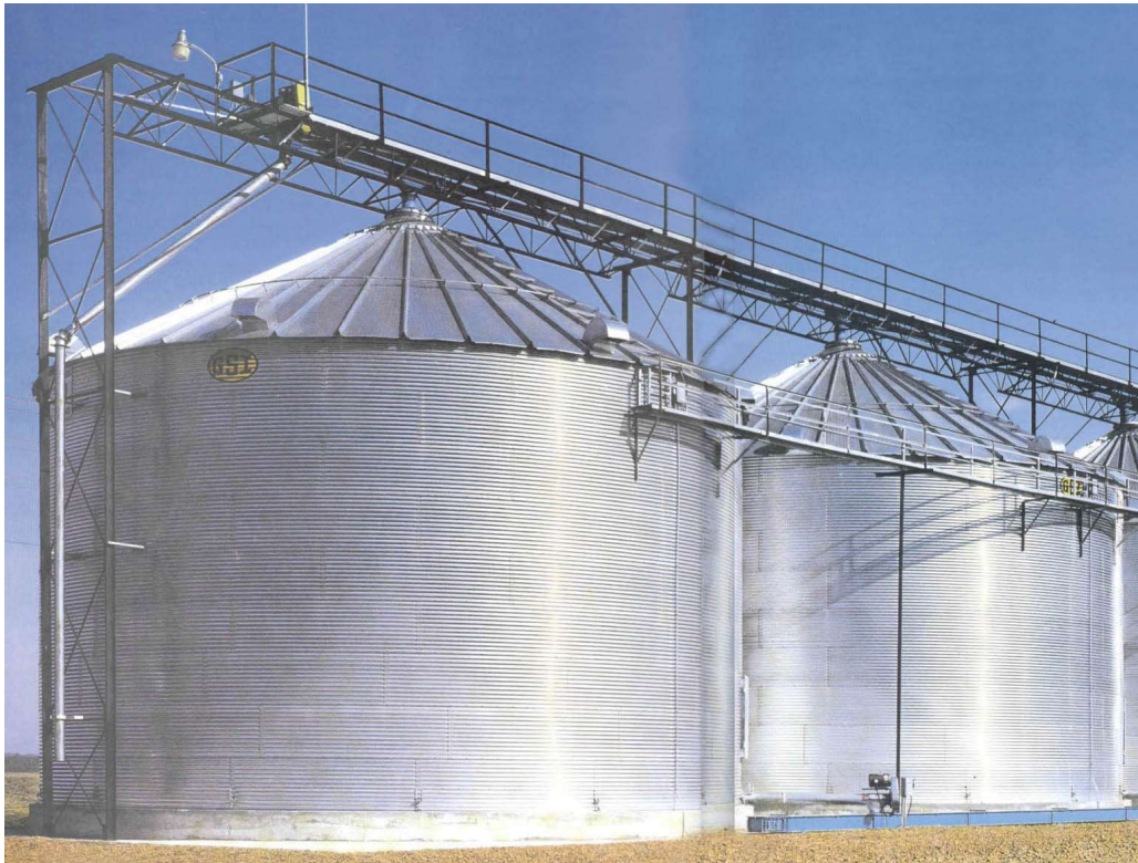
Figura 2.3 – Conjunto de Silos Horizontais em Chapas Metálicas Fonte: GSI – Grain Systems Inc, 2002.
