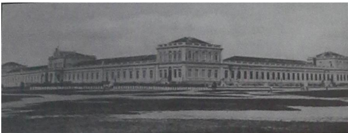
Figura 07- Escola Militar da Província do Rio Grande do Sul (1883-1888), primeiro prédio do atual Colégio Militar de Porto Alegre.
