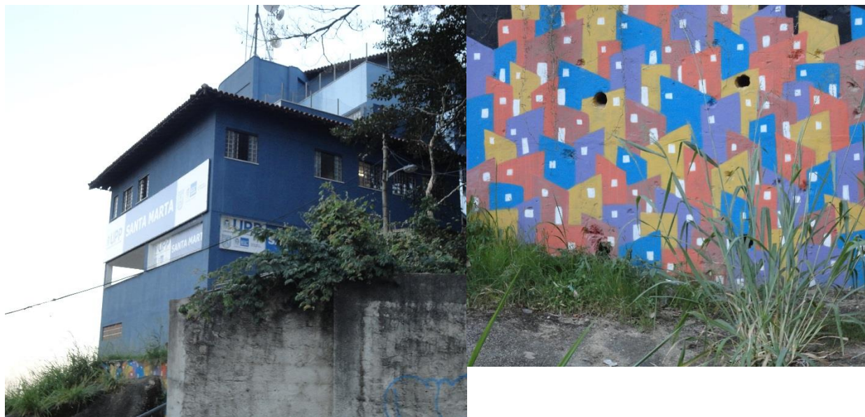
Figura 11 – Sede da UPP e muro com marcas de balas de fuzil
