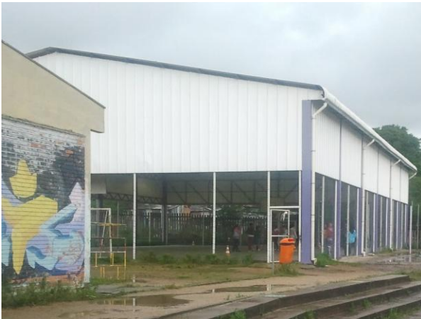
Foto 1: quadra coberta e fechada
