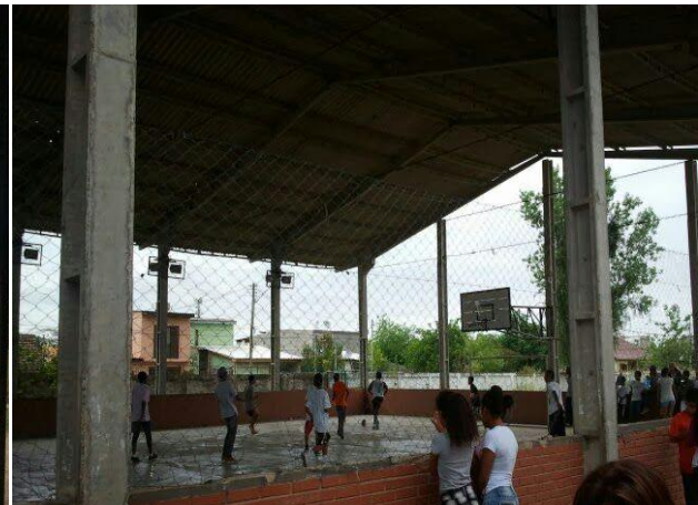
Foto 5: quadra coberta e fechada
