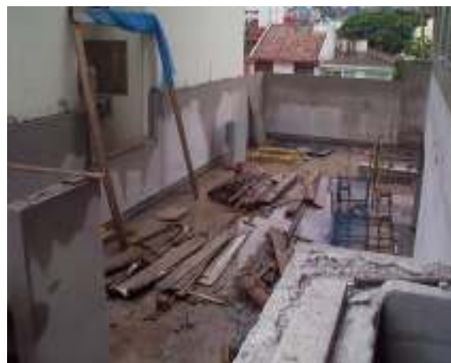
Figura 29: Vista do canteiro de obras
