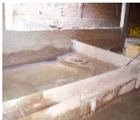
Figura 36: Argamassa antiga deixada no final da masseira
