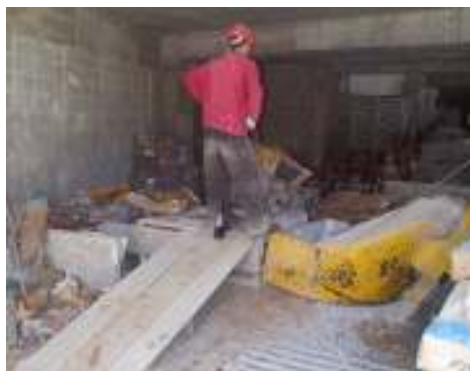
Figura 56: Descarregamento de areia no carregador da betoneira
