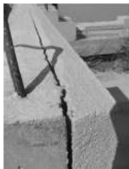
Figura 5: Descolamento do revestimento na interface substrato-revestimento
