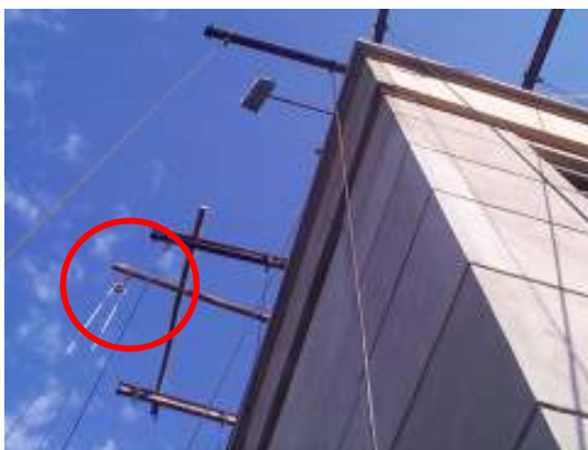
Figura 67: Sistema de roldanas para fornecimento de argamassa
