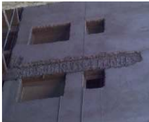
Figura 59: Viga cortada para diminuição das espessuras de revestimento na fachada
