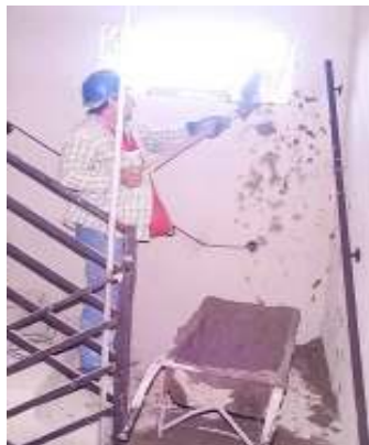
Figura 38: Transporte de argamassa com pá para abastecer andaime
