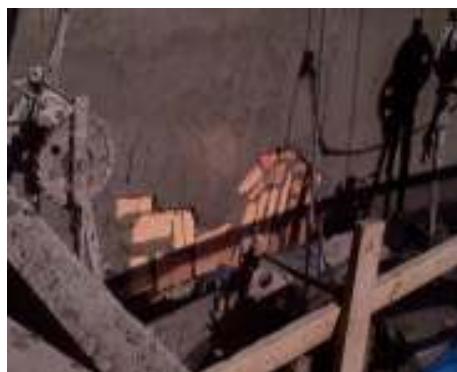
Figura 64 (a) e (b): Desprendimento de argamassa da base e encasquilhamento com pedaços de cerâmica
