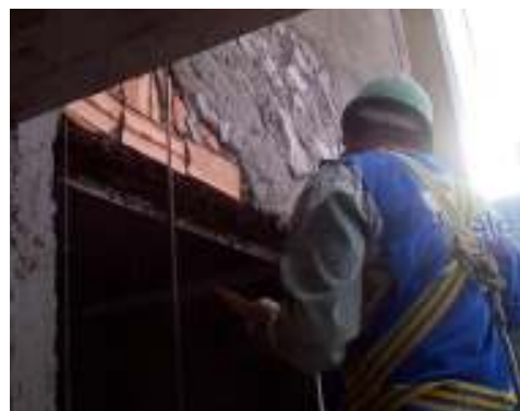
Figura 64 (a) e (b): Desprendimento de argamassa da base e encasquilhamento com pedaços de cerâmica
