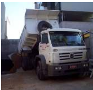
Figura 26: Chegada de areia no canteiro de obras sendo descarregada diretamente no local de armazenamento
