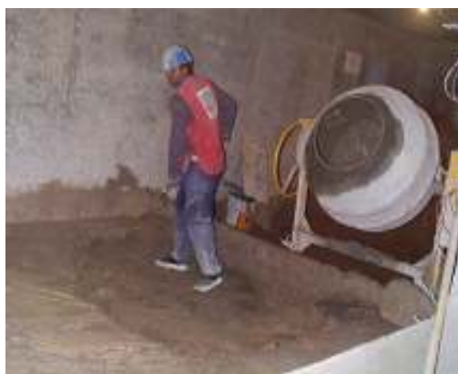
Figura 35: Transporte da argamassa intermediária da masseira para betoneira
