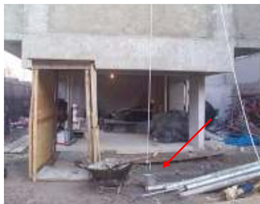
Figura 68: Uso de balde para transportar e fornecer argamassa para o andaime
