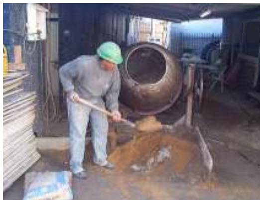
Figura 66: Utilização de pá para proporcionamento de areia para produção de argamassa
