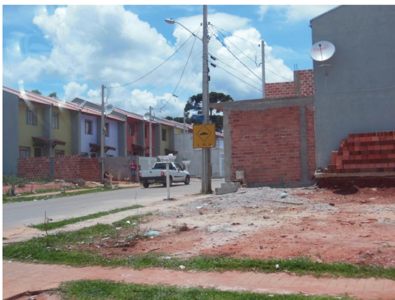
Figura 7: Empreendimento visitado: Moradias Boa Esperança - 2012
