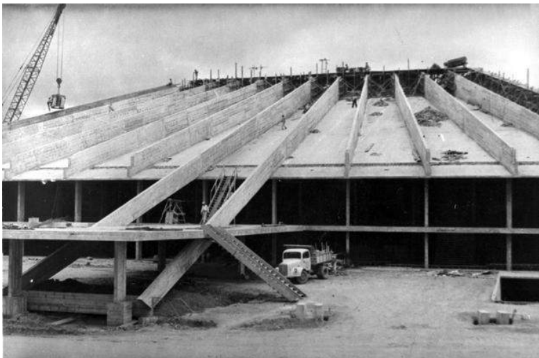
Fig. 25 Obras do Teatro Nacional. Fonte: Arquivo Público do Distrito Federal.
