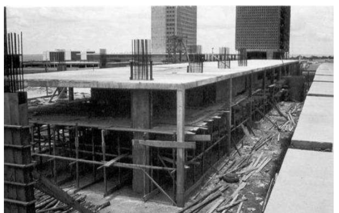
Fig. 49. Registro da construção, 1964. Fonte: Acervo Touring Club do Brasil.
