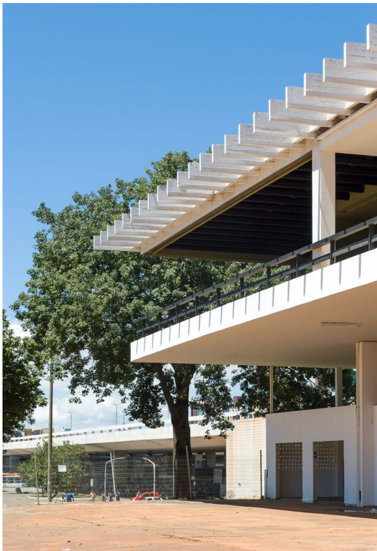
Fig. 44. Detalhe da fachada leste. Fonte: Joana França
