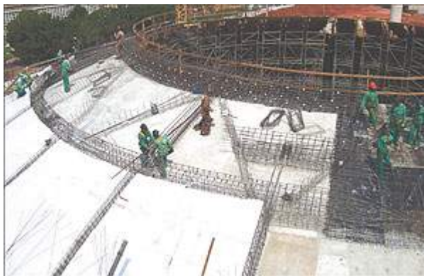
Fig. 104. (esq.) Execução das vigas circunferenciais e radiais do Museu Nacional. Fonte: Revista Techne.
