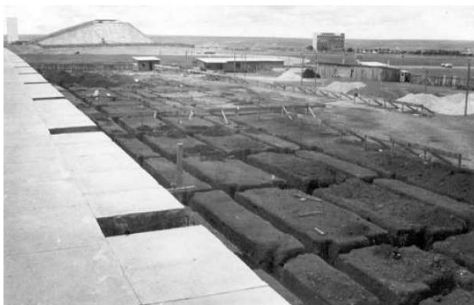
Fig. 48. Registro da construção, 1964. Fonte: Acervo Touring Club do Brasil.
