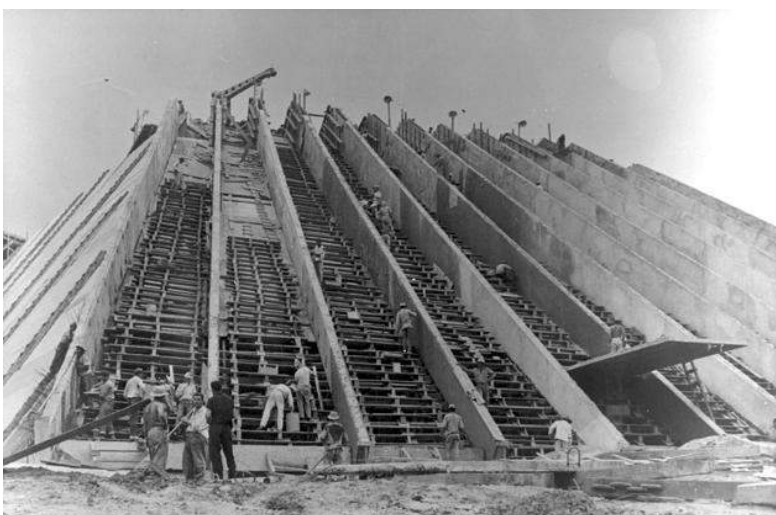
Fig. 26 Obras do Teatro Nacional Fonte: Arquivo Público do Distrito Federal.
