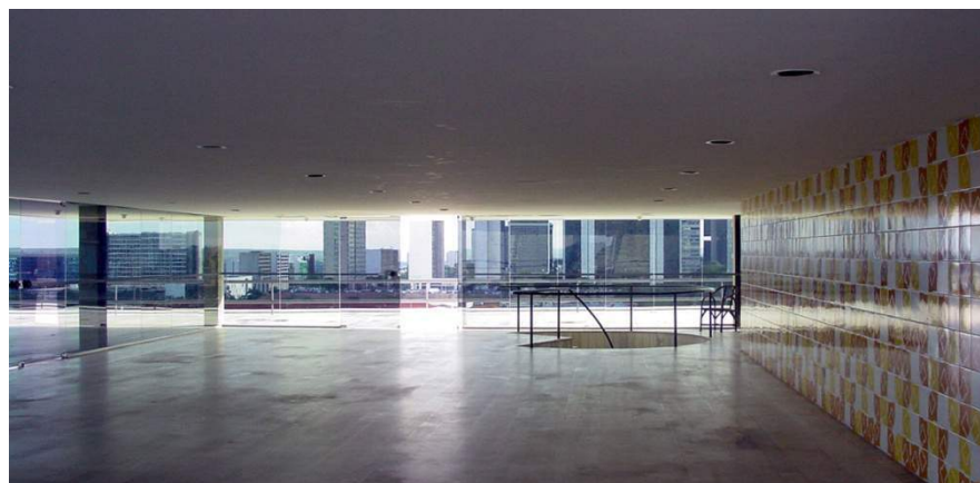
Fig. 23. Restaurante com painel de azulejos de Athos Bulcão. Fonte: www.brazilia.jor.br , 2003.
