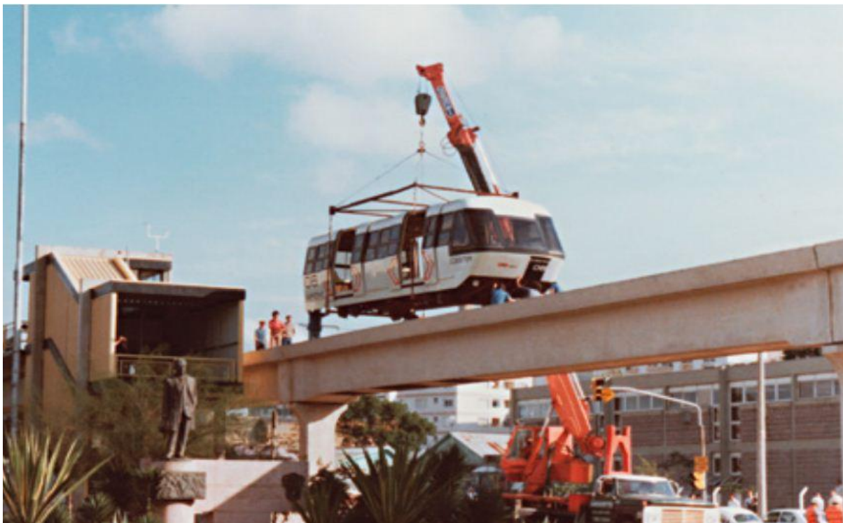
Figura 5 - Instalação do veículo no trecho experimental Fonte: AEROMÓVEL BRASIL, 2011.
