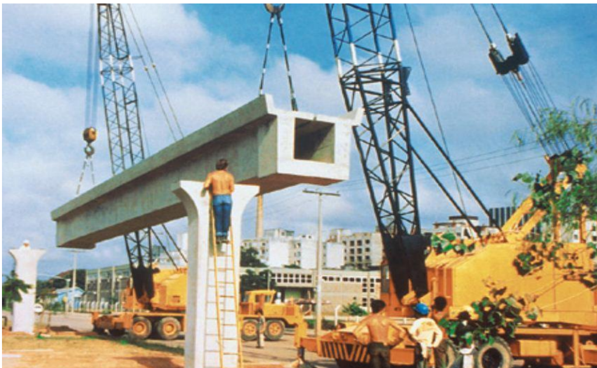
Figura 4 - Linha Piloto começa a ser construída Fonte: AEROMÓVEL BRASIL, 2011.
