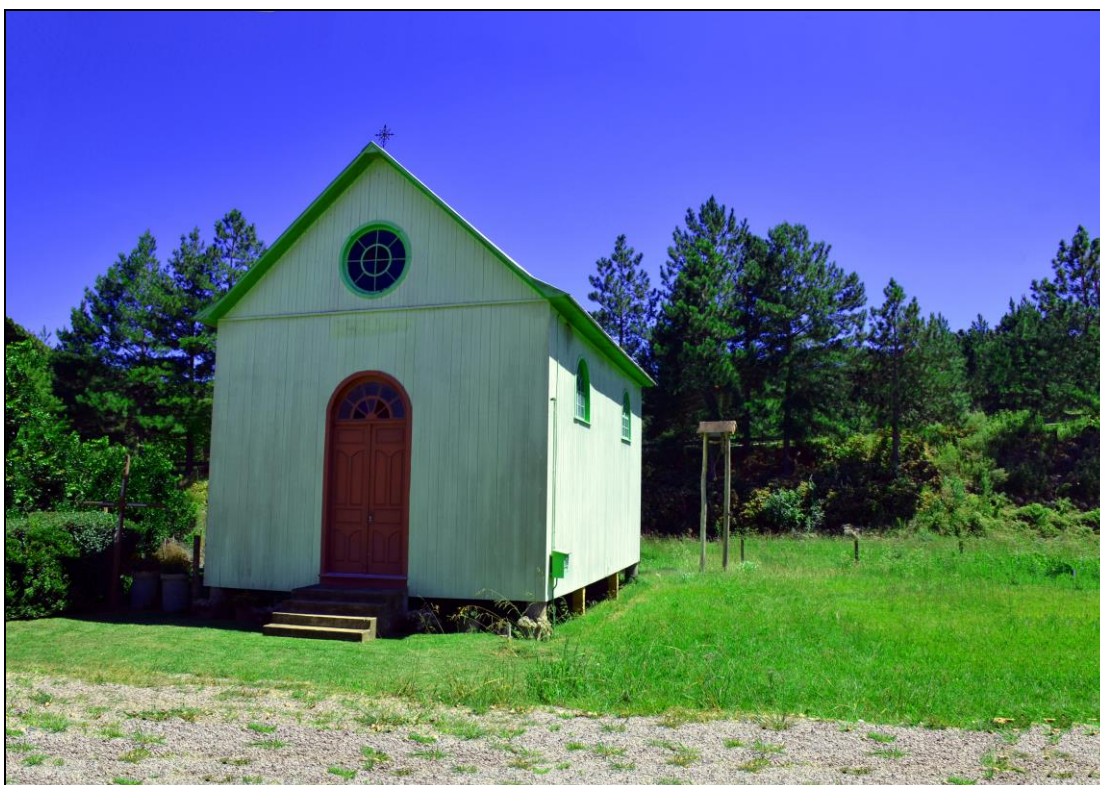
Figura 29 - Igreja de Santo Agostinho, em Boca da Serra, construída em 1932.
