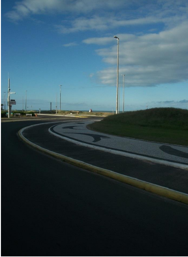
Figura 14 - Final da Ciclovia e do Calçadão
