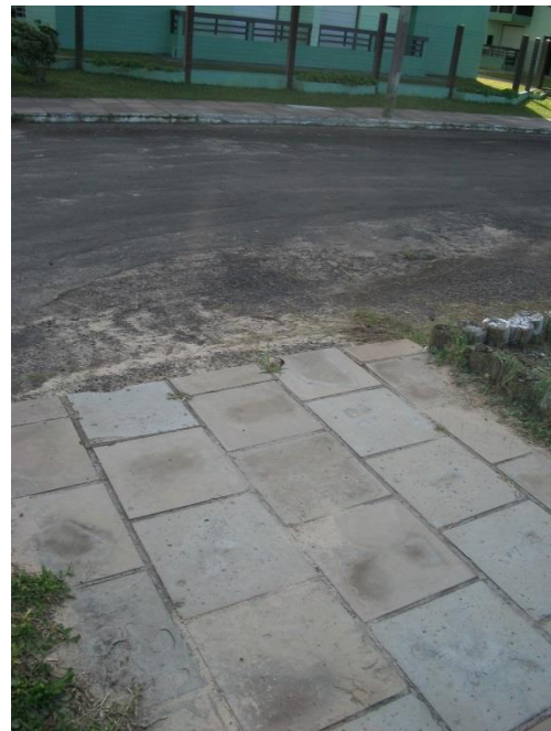
Figura 31 - Calçada sem rampa de acesso
