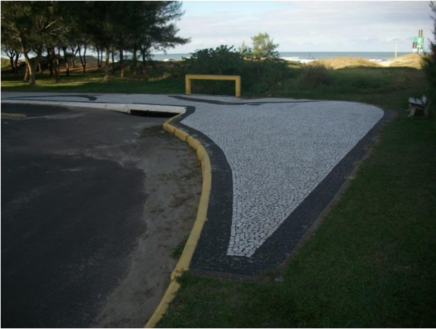
Figura 4 - Início do Calçada. Sem rampa de acesso
