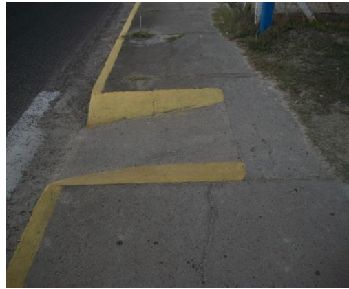
Figura 86 - Rampa de acesso
