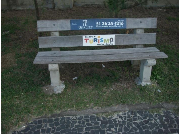
Figura 7 - Banco em bom estado de conservação
