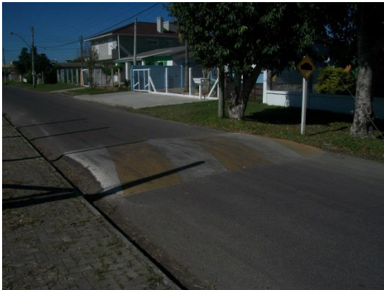
Figura 92 - Lombada de desaceleração
