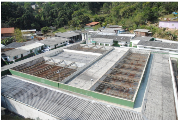
Figura 13 – Vista geral da unidade atualmente
