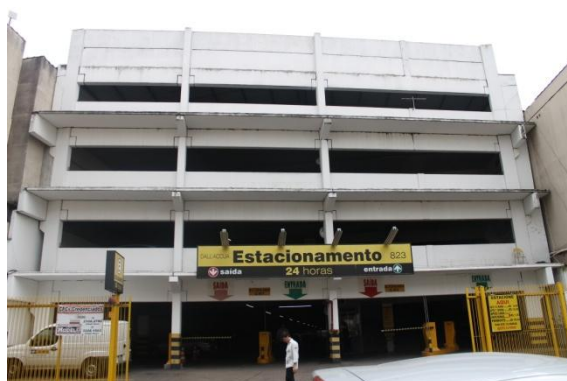
FIG. 28: Foto estacionamento da Rua Sarmento Leite
