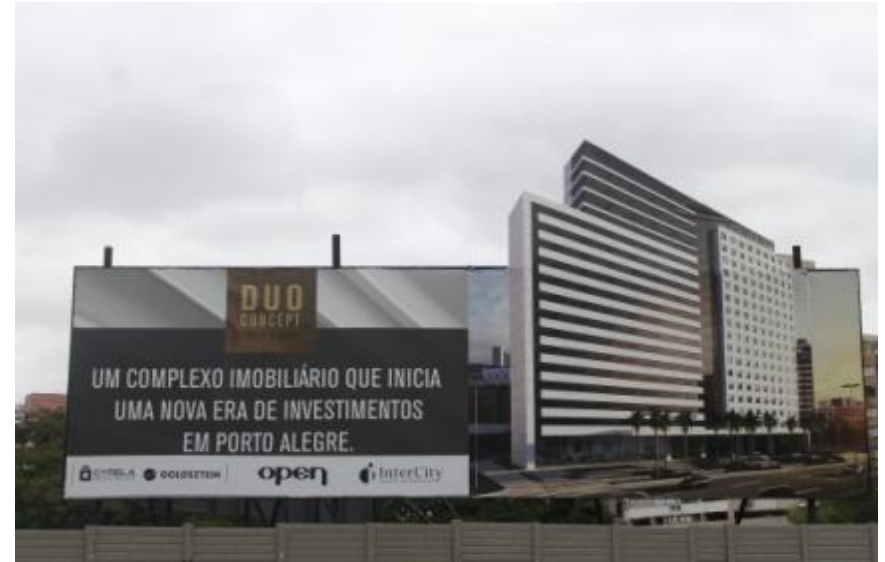
FIG. 21: Empreendimento em construção entre a Av. Loureiro da Silva e a Rua Havaí
