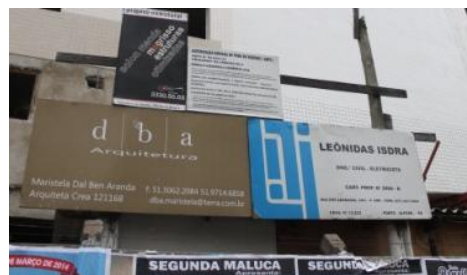
FIG. 12: Construção na esquina da Av. Loureiro da Silva com a Rua G.al Lima e Silva.
