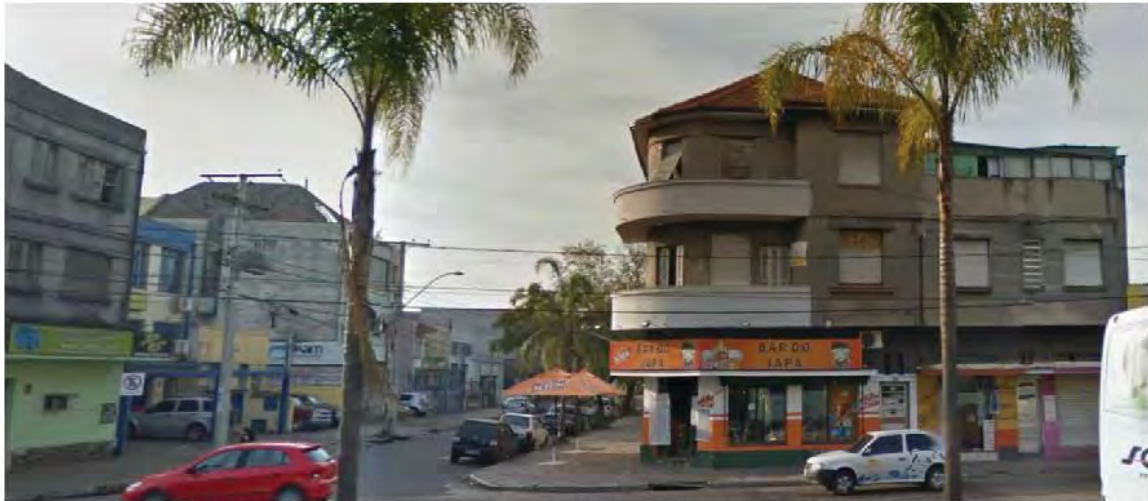
Figura 4 Deterioração e intervenção em edifício do estilo Art Decô - Avenida Farrapos.
