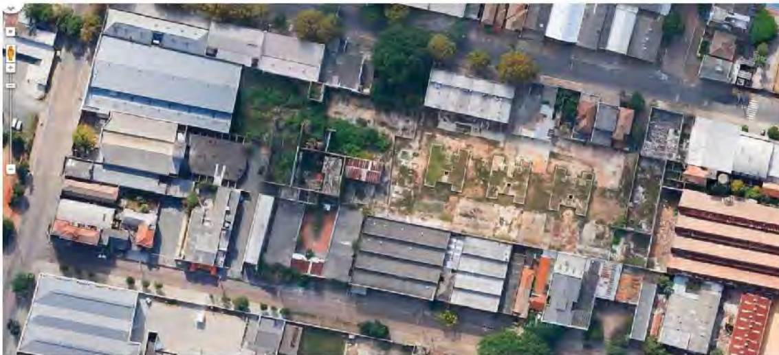
Figura 10 Miolo de quadra subutilizado entre as ruas Dr. João Inácio e Comendador Tavares - Bairro Navegantes.
