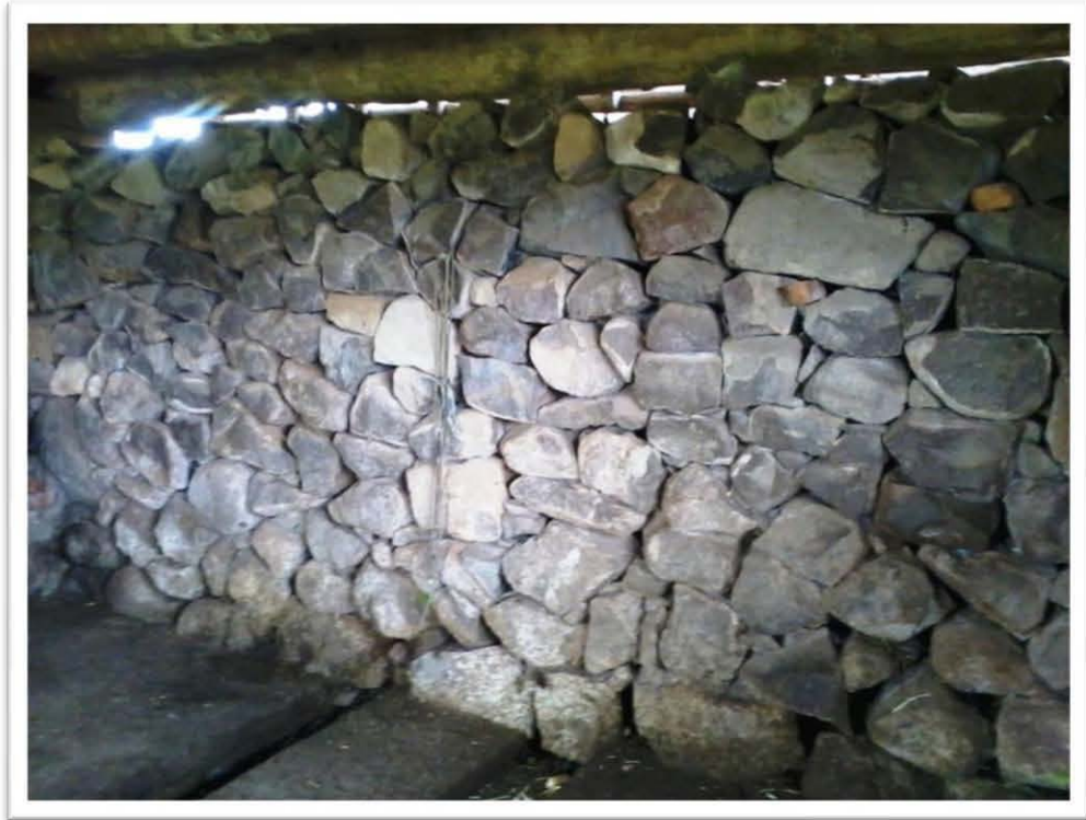
Imagem 11: Taipa em porão
