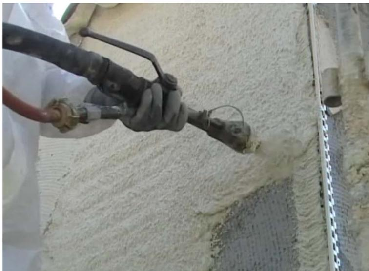
Figura 5: vista geral da projeção da argamassa decorativa monocamada (adaptado de <http://www.youtube.com/watch?v=LJS5RYGCT7s>)
