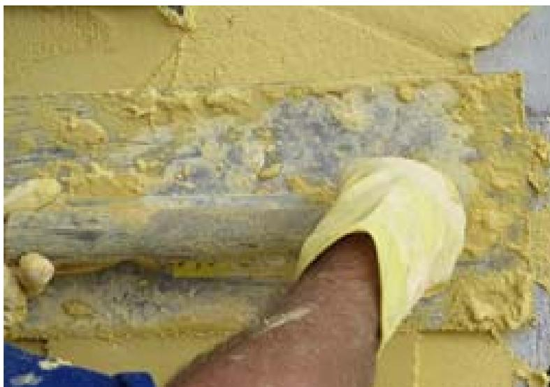
Figura 7: Aplicação manual do revestimento decorativo monocamada (adaptado de [http://www.aecweb.com.br/cont/n/revestimento-monocamada-pede-projeto\\_5759](http://www.aecweb.com.br/cont/n/revestimento-monocamada-pede-projeto_5759))
