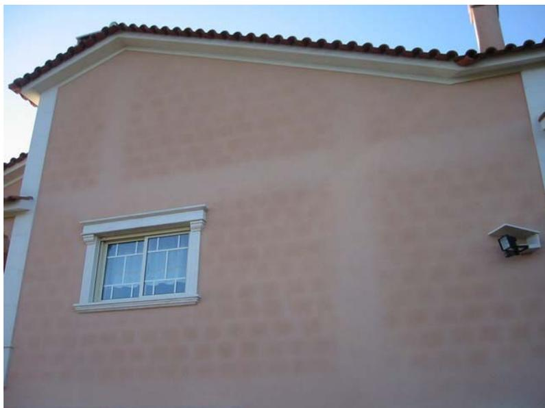
Figura 2: aparecimento de “fantasmas” em revestimentos decorativo monocamada (FREITAS e ALVES, 2009)
