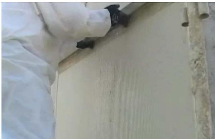
Figura 6: regularização feita logo após a aplicação da segunda camada (adaptado de <http://www.youtube.com/watch?v=LJS5RYGCT7s>)
