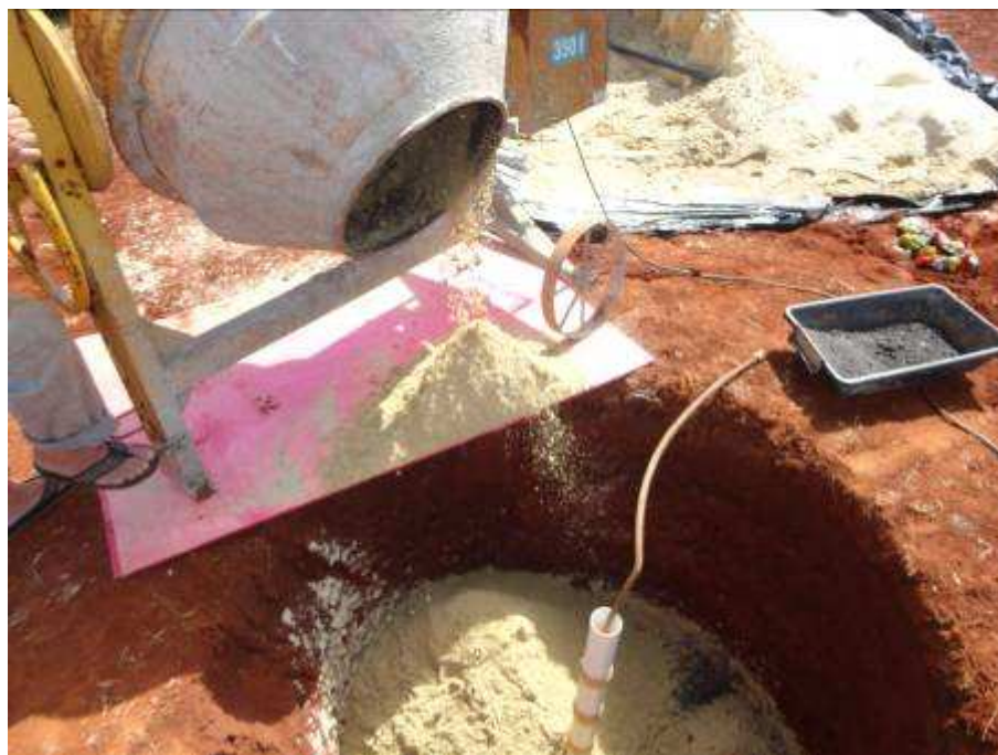
Figura 3.18: Lançamento da areia na cava para compactação.
