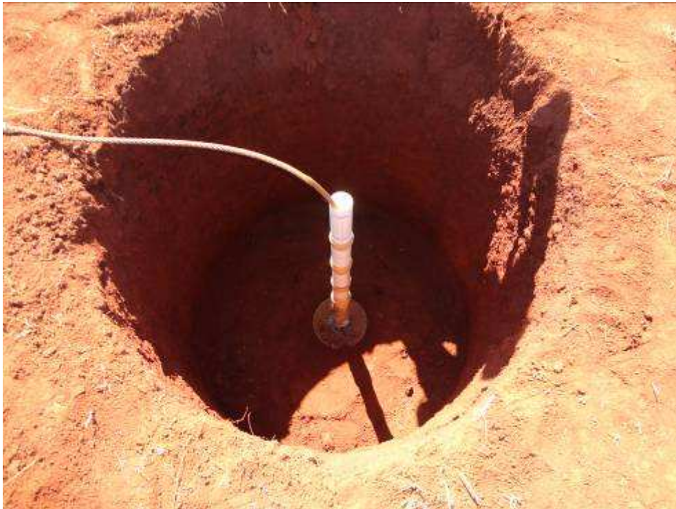
Figura 3.14: Imagem da escavação realizada para execução dos ensaios
