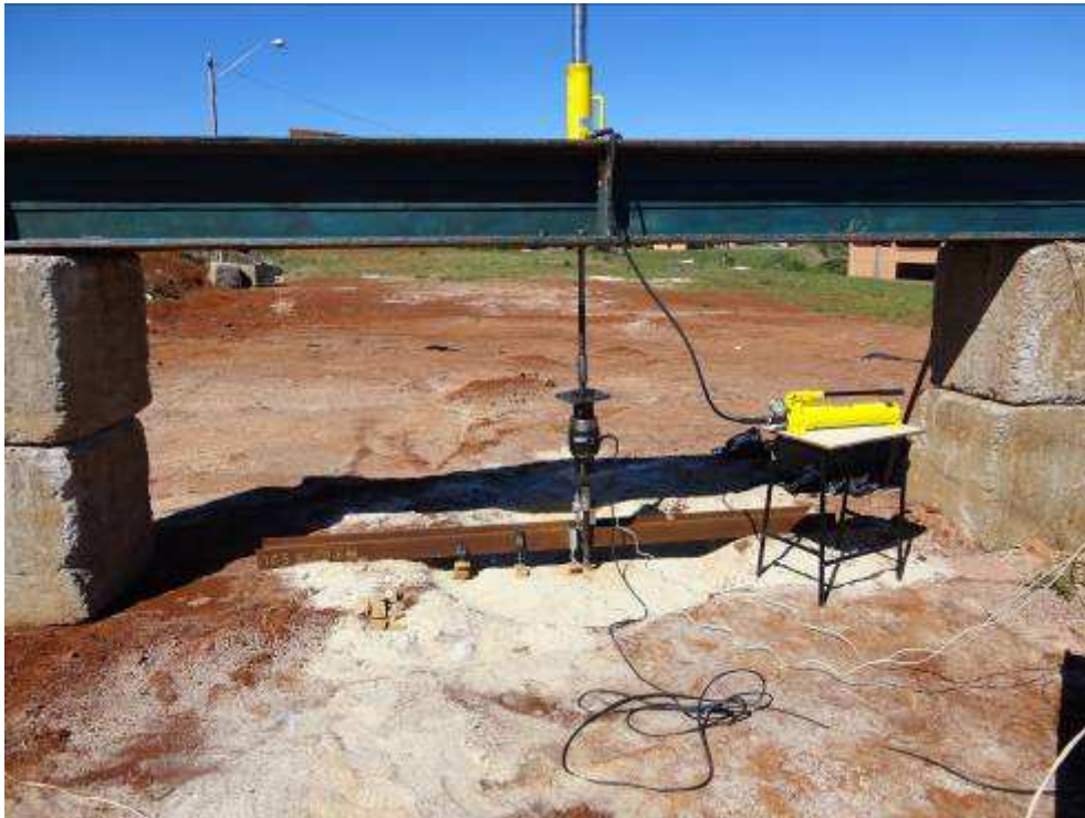
Figura 3.11: Sistema de reação e aplicação de carga.
