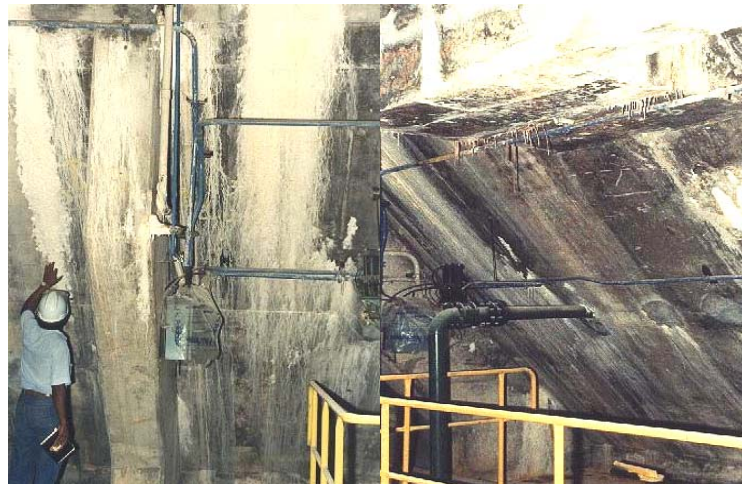
Figura 68 - Visualización de eflorescencias (PAZINI-O'REILLY, 2003)
