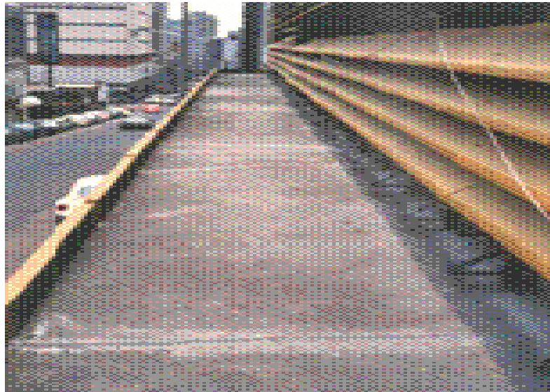
Figura 7 - Fisuración por variación térmica ambiental (PAZINI-O'REILLY, 2003)
