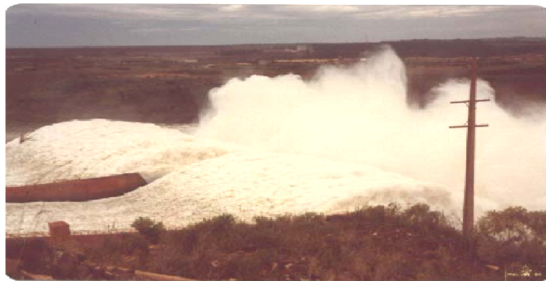
Figura 54 – Estructura expuesta a cavitación (PAZINI-O´REILLY, 2003)
